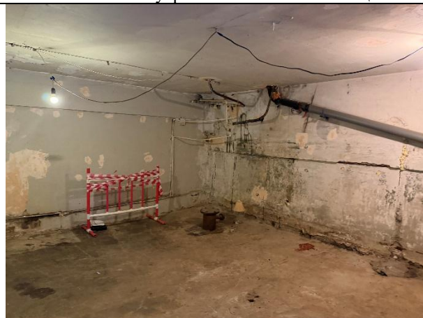
Фото № 12 – Внутреннее состояние помещения
