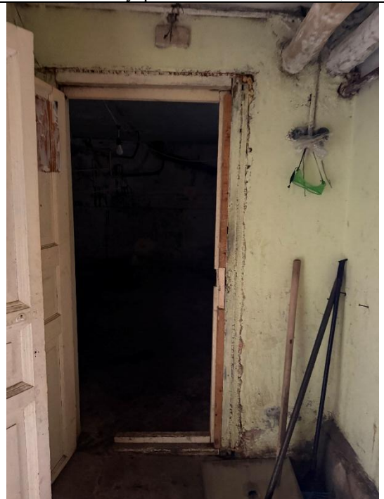
Фото № 8 – Внутреннее состояние помещения
