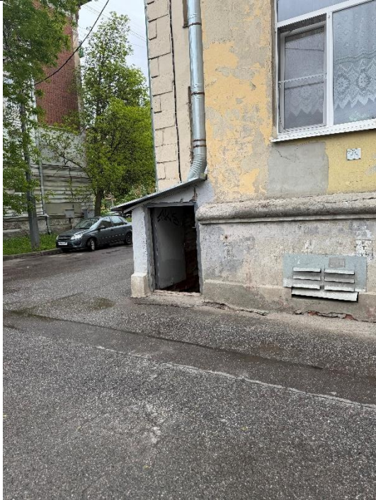
Фото № 5 – Вход в помещение со двора
