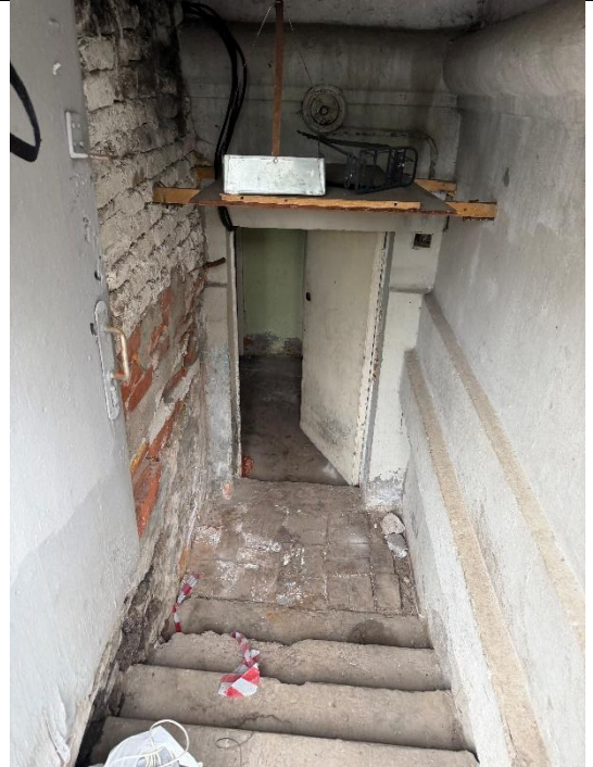
Фото № 6 – Внутреннее состояние помещения
