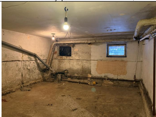
Фото № 11 – Внутреннее состояние помещения
