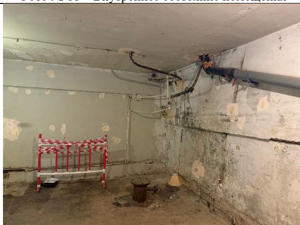
Фото № 13 – Внутреннее состояние помещения
