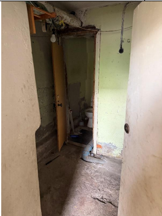
Фото № 7 – Внутреннее состояние помещения
