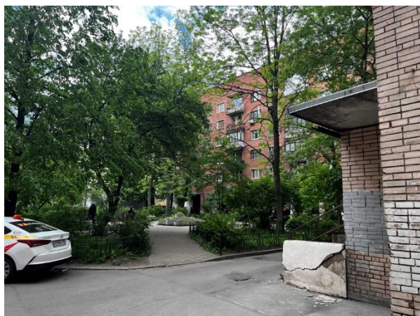
Фото 3. Вид здания Объекта оценки. Дворовая территория
