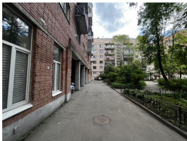
Фото 4. Вид здания Объекта оценки. Дворовая территория
