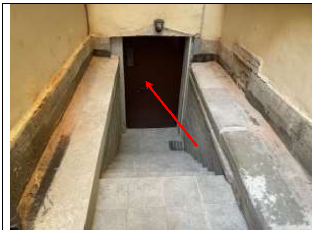
Фото 21. Входная группа Объекта оценки (помещение 3-Н)
