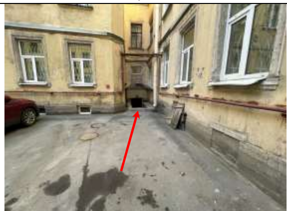
Фото 19. Входная группа Объекта оценки (помещение 3-Н)
