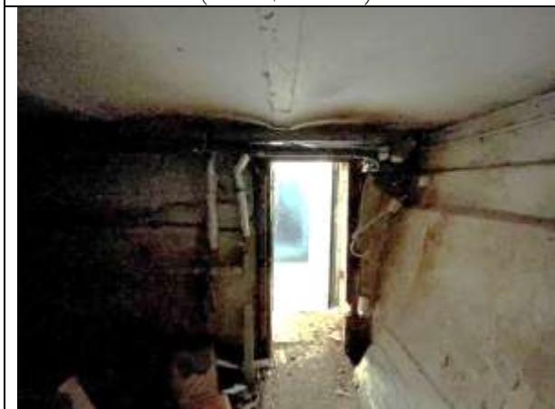
Фото 25. Типичное состояние Объекта оценки
