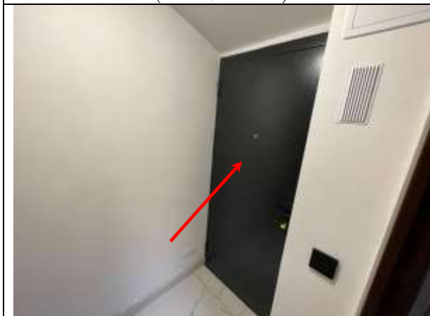
Фото 23. Входная группа Объекта оценки (помещение 3-Н)
