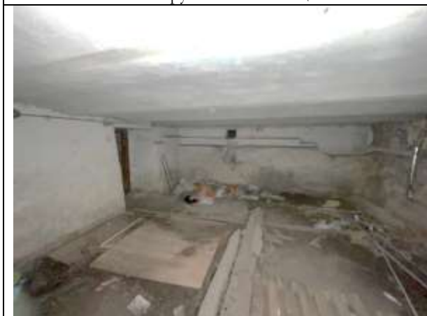
Фото 31. Типичное состояние Объекта оценки
