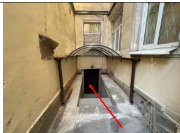
Фото 20. Входная группа Объекта оценки (помещение 3-Н)
