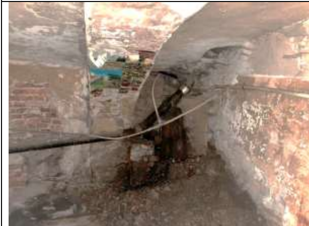
Фото 19. Типичное состояние Объекта оценки
