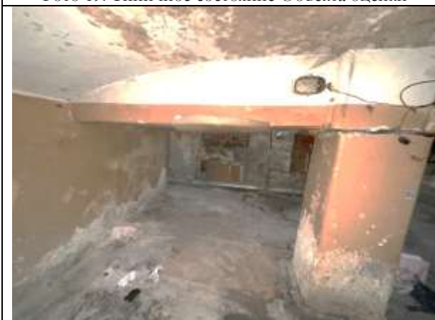
Фото 21. Типичное состояние Объекта оценки
