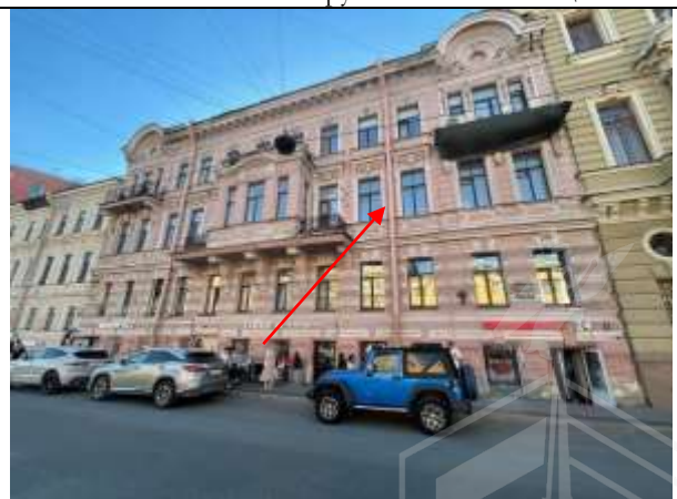
Фото 8. Вид здания, в котором расположен Объект оценки
