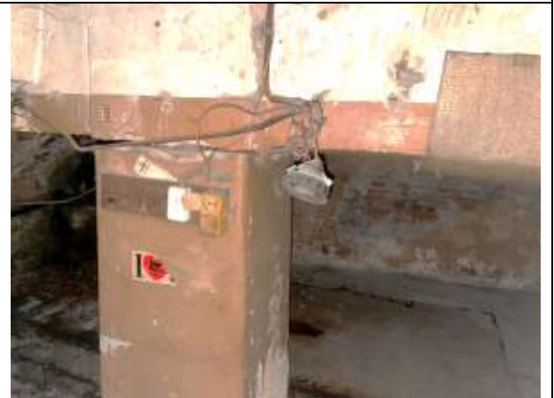
Фото 20. Типичное состояние Объекта оценки
