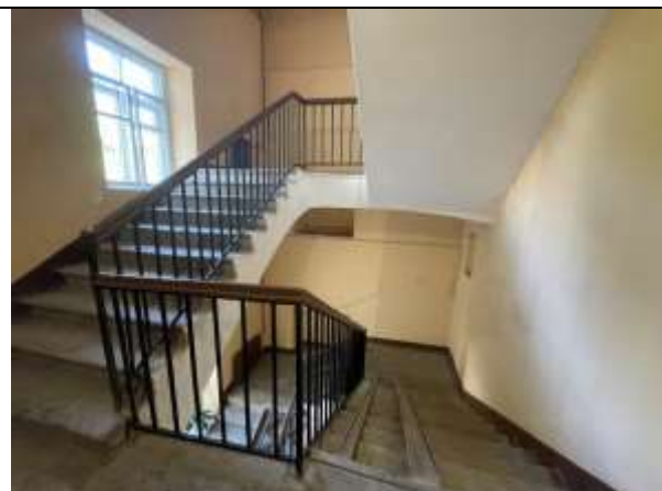
Фото 23. Лестничный проём здания, в котором расположен Объект оценки
