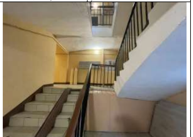
Фото 22. Лестничный проём здания, в котором расположен Объект оценки
