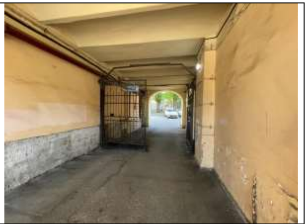
Фото 18. Проход через арку к Объекту оценки
