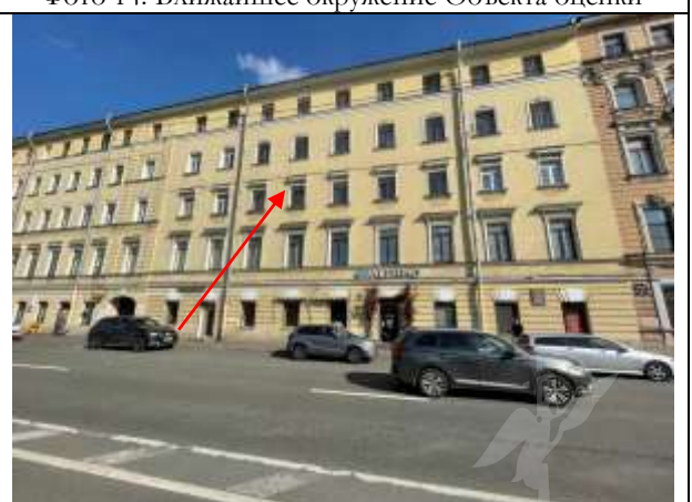
Фото 16. Вид здания, в котором расположен Объект оценки
