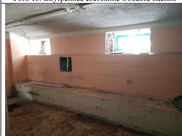
Фото 15. Внутреннее состояние Объекта оценки
