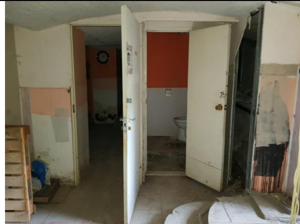
Фото 21. Внутреннее состояние Объекта оценки
