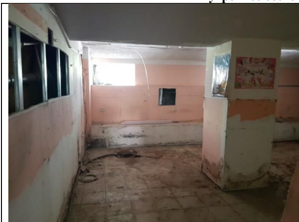
Фото 9. Внутреннее состояние Объекта оценки
