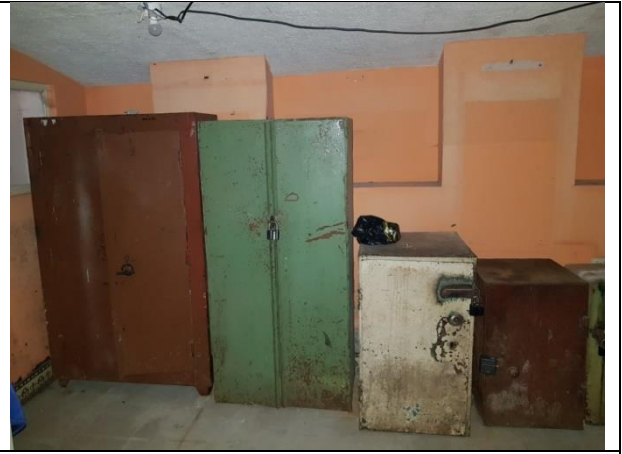
Фото 20. Внутреннее состояние Объекта оценки
