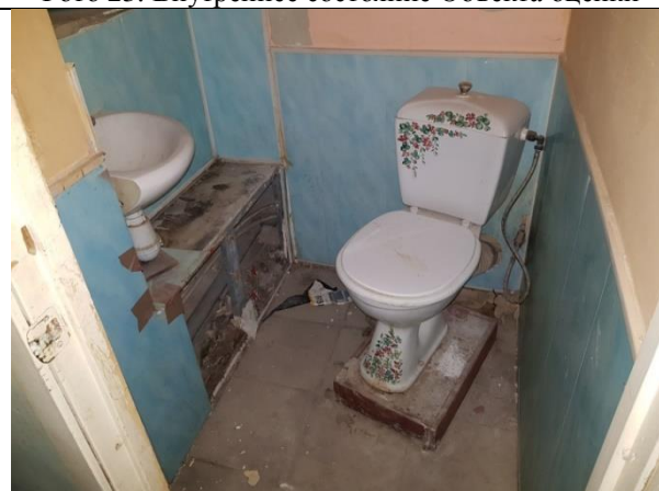
Фото 25. Внутреннее состояние Объекта оценки
