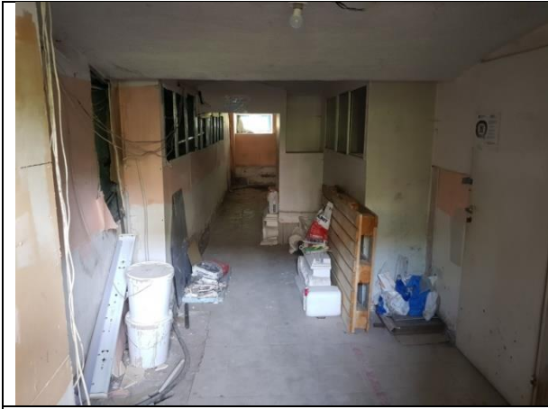
Фото 35. Внутреннее состояние Объекта оценки
