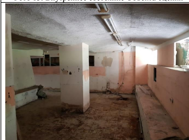
Фото 17. Внутреннее состояние Объекта оценки
