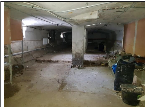
Фото 27. Внутреннее состояние Объекта оценки
