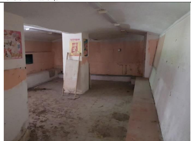
Фото 10. Внутреннее состояние Объекта оценки
