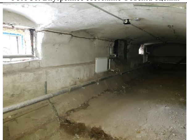
Фото 32. Внутреннее состояние Объекта оценки
