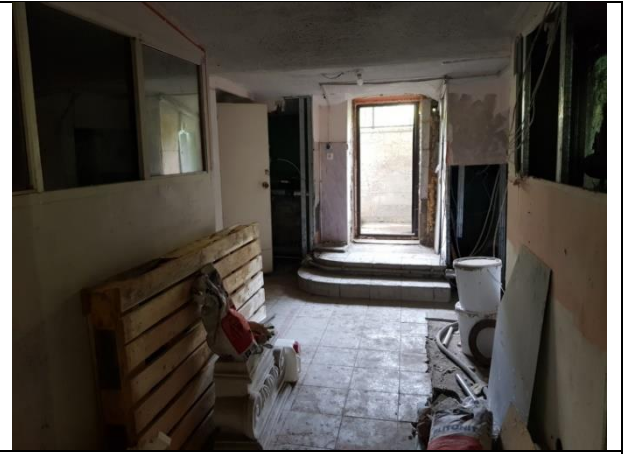
Фото 36. Внутреннее состояние Объекта оценки
