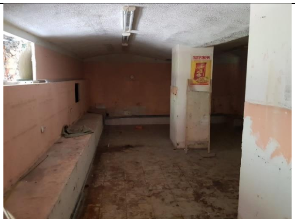
Фото 12. Внутреннее состояние Объекта оценки
