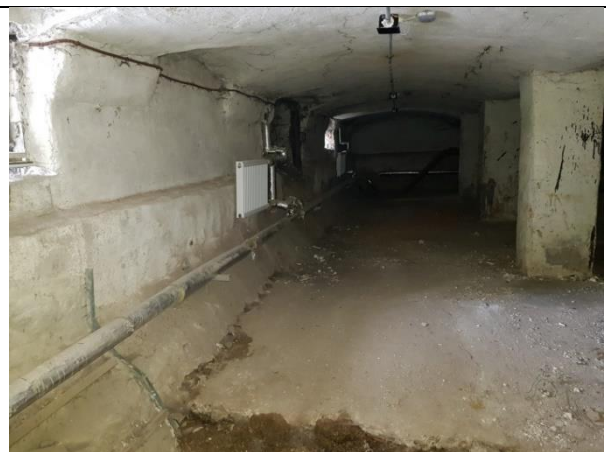
Фото 28. Внутреннее состояние Объекта оценки
