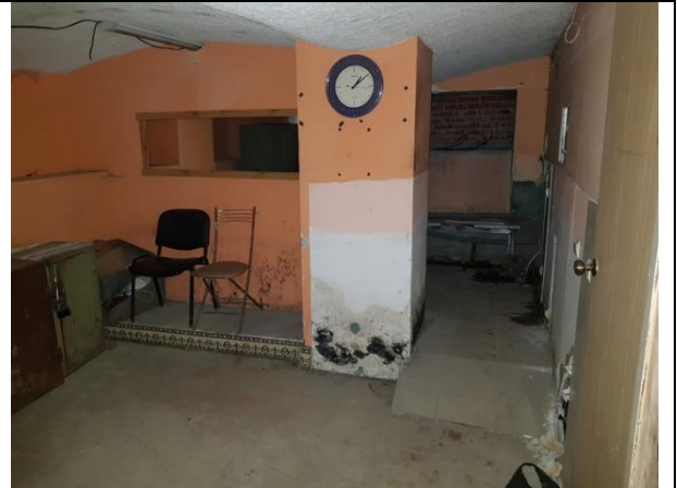
Фото 22. Внутреннее состояние Объекта оценки
