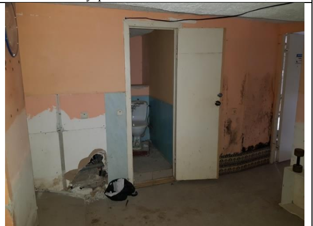
Фото 24. Внутреннее состояние Объекта оценки
