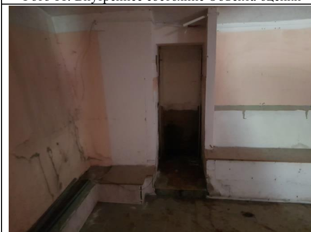
Фото 13. Внутреннее состояние Объекта оценки
