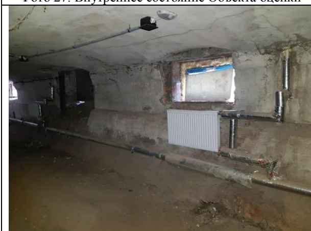
Фото 29. Внутреннее состояние Объекта оценки
