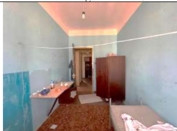
Фото 25. Типичное состояние Объекта оценки
