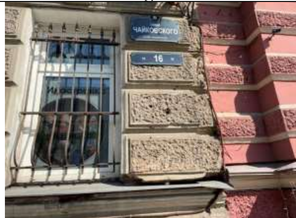
Фото 11. Адрес здания, в котором расположен Объект оценки
