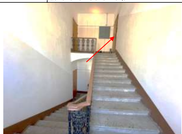
Фото 18. Лестничный проём здания, в котором расположен Объект оценки, входная группа Объекта оценки
