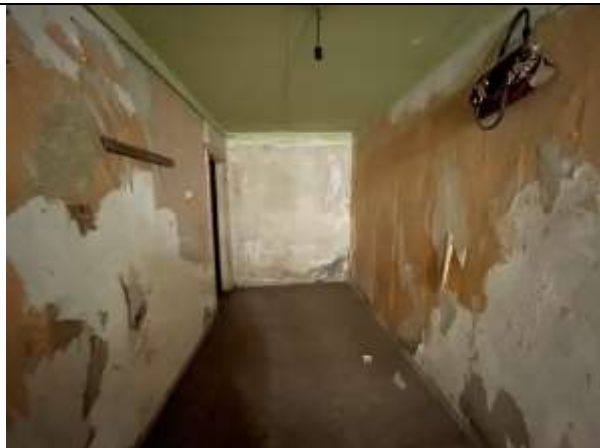
Фото 19. Типичное состояние Объекта оценки
