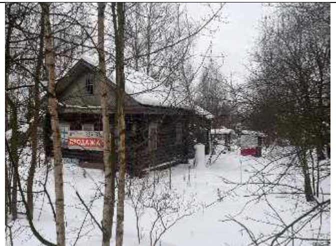
Фото 4 Вид на оцениваемый жилой дом.
