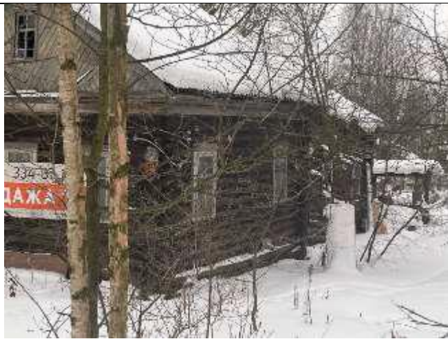
Фото 3 Вид на оцениваемый жилой дом.
