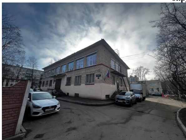
Фото 1. Вид здания Объекта оценки
