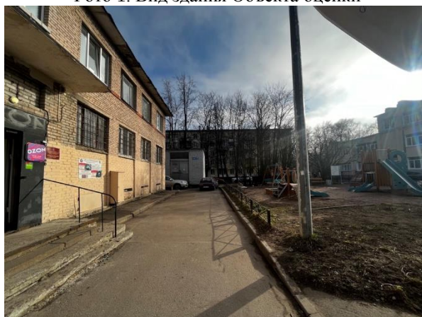
Фото 3. Вид здания Объекта оценки. Дворовая территория
