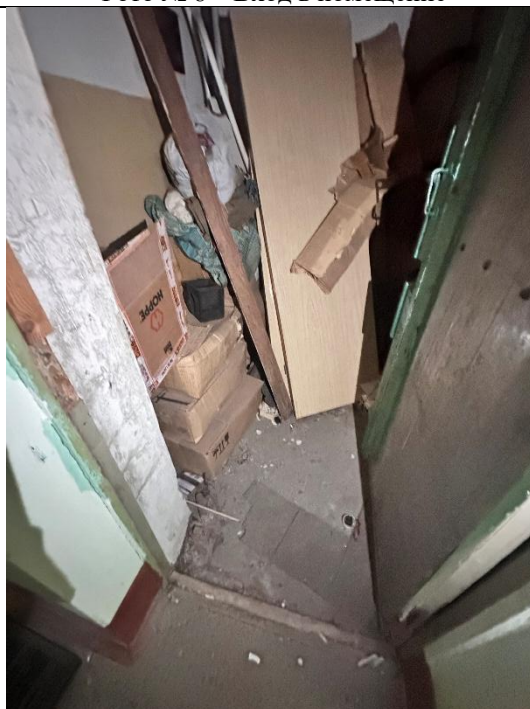
Фото № 10 – Внутреннее состояние помещения
