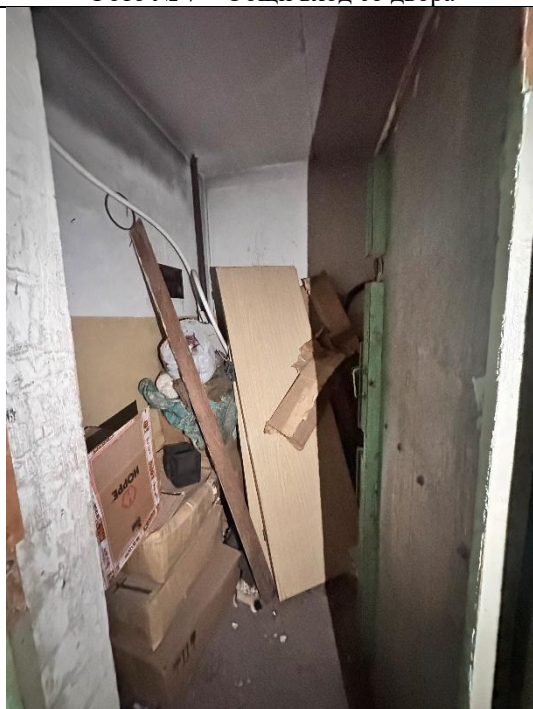
Фото № 9 – Внутреннее состояние помещения
