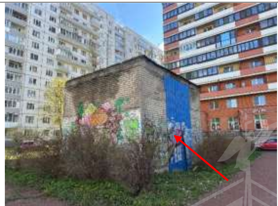
Фото 14. Вид здания расположения Объекта оценки
