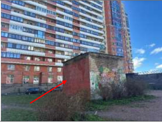
Фото 15. Вид здания расположения Объекта оценки
