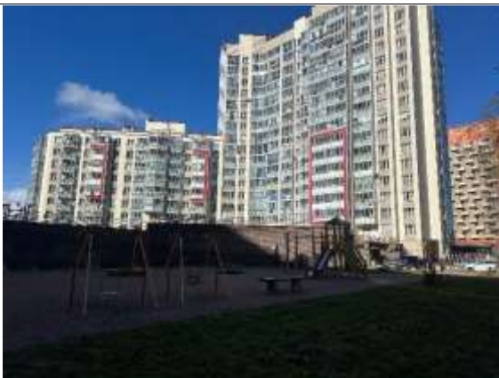
Фото 13. Внутридворовая территория Объекта оценки
