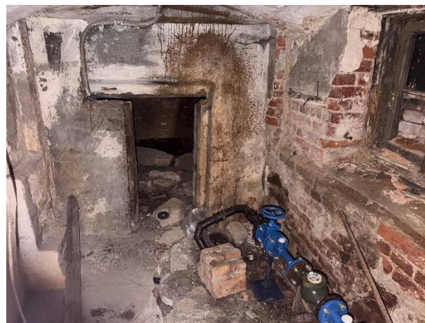
Фото № 8 – Внутреннее состояние помещения
