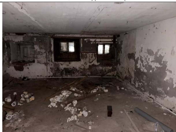
Фото № 9 – Внутреннее состояние помещения
