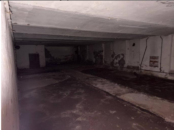
Фото № 17 – Внутреннее состояние помещения
