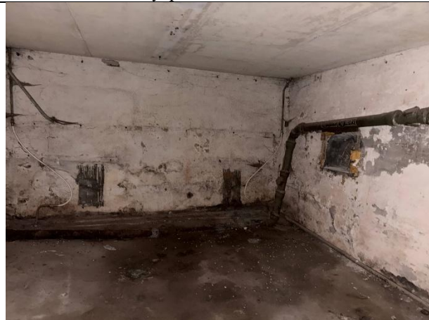
Фото № 11 – Внутреннее состояние помещения
