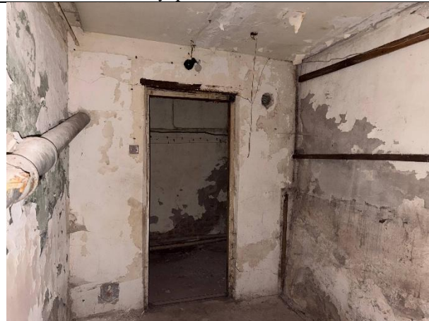
Фото № 12 – Внутреннее состояние помещения
