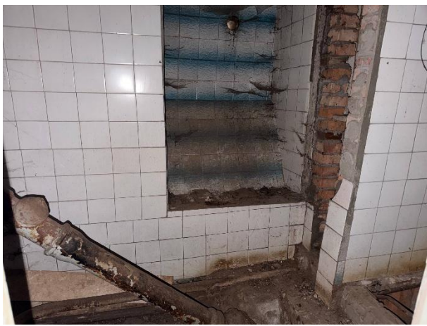
Фото № 15 – Внутреннее состояние помещения
