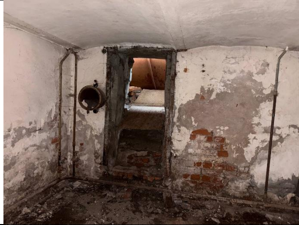
Фото № 19 – Внутреннее состояние помещения
