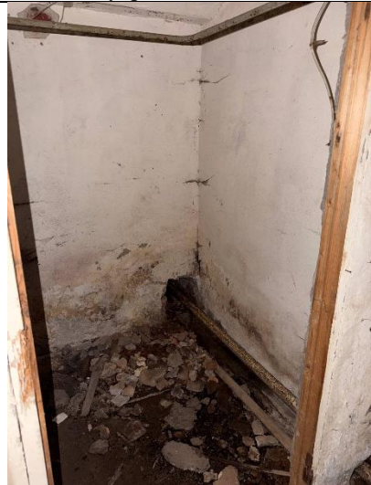
Фото № 16 – Внутреннее состояние помещения
