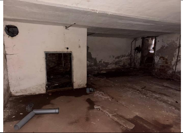
Фото № 20 – Внутреннее состояние помещения
