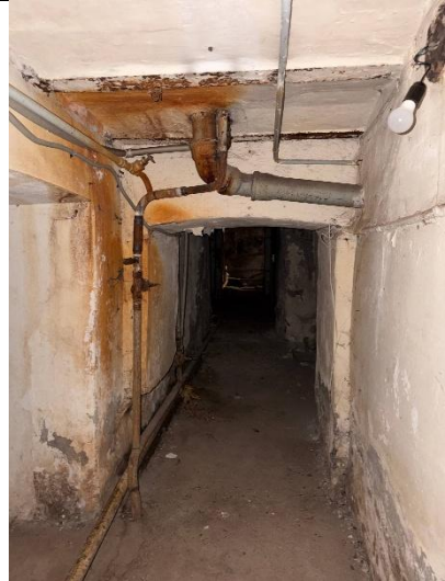
Фото № 14 – Внутреннее состояние помещения
