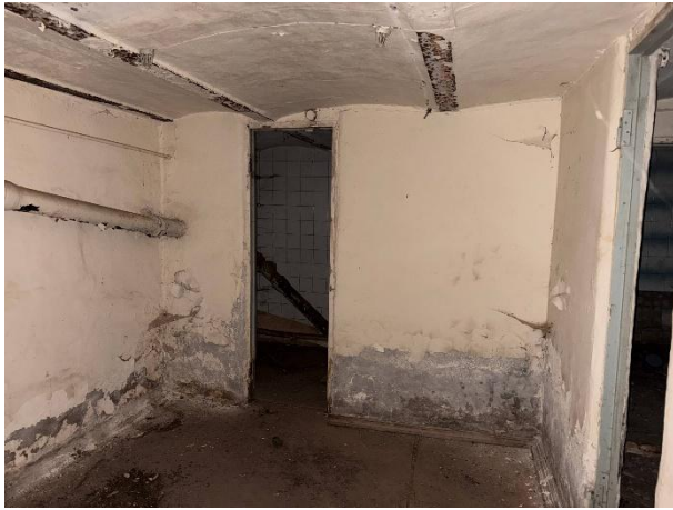
Фото № 13 – Внутреннее состояние помещения
