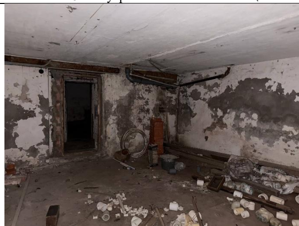
Фото № 10 – Внутреннее состояние помещения
