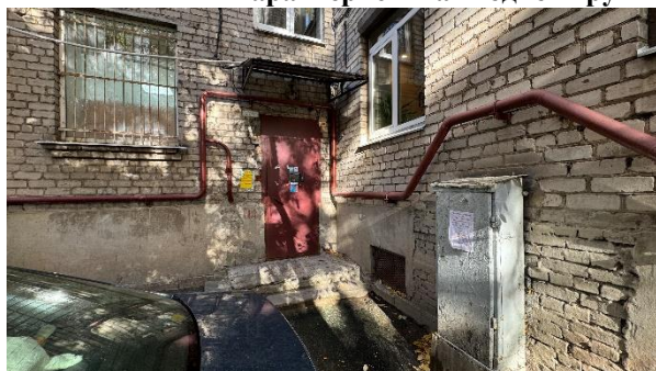
Фото 5. Общий вход со двора
