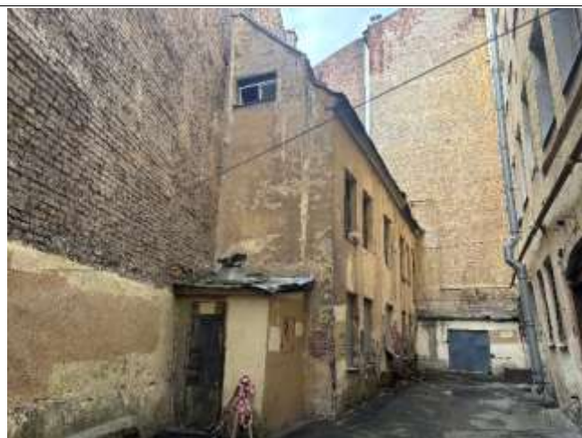
Фото 32. Вид здания расположения Объекта оценки
