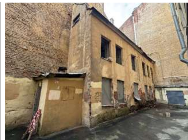
Фото 31. Вид здания расположения Объекта оценки
