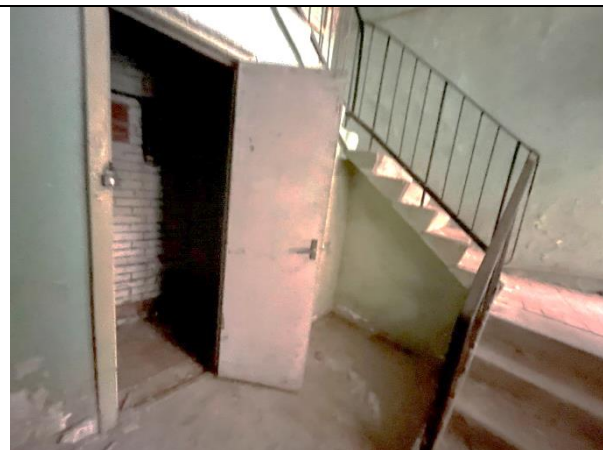
Фото 56. Лестничный проём Объекта оценки
