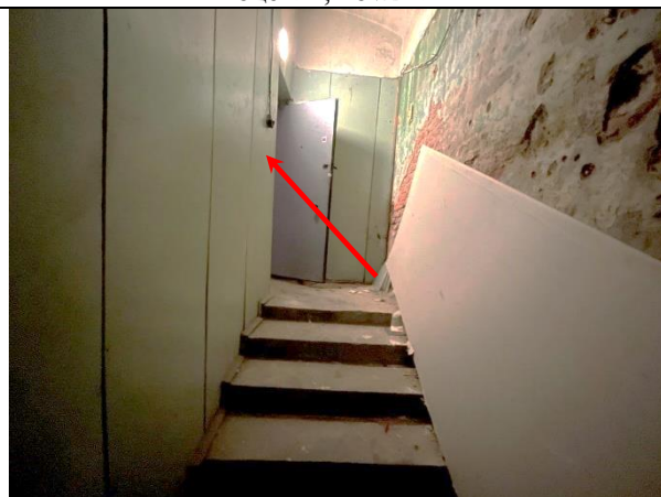
Фото 43. Лестничный проём здания, в котором расположен Объект оценки, входная группа Объекта оценки, пом.2-Н
