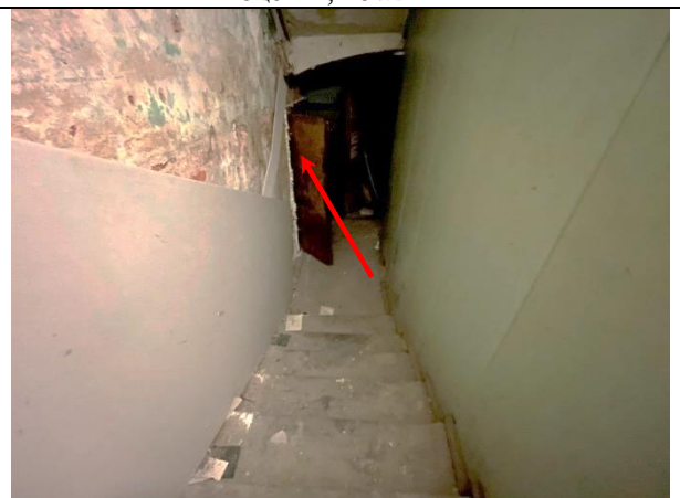
Фото 44. Лестничный проём здания, в котором расположен Объект оценки, входная группа Объекта оценки, пом.2-Н
