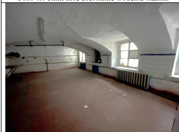
Фото 51. Типичное состояние Объекта оценки
