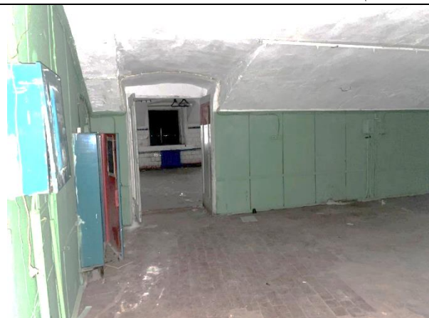
Фото 60. Типичное состояние Объекта оценки
