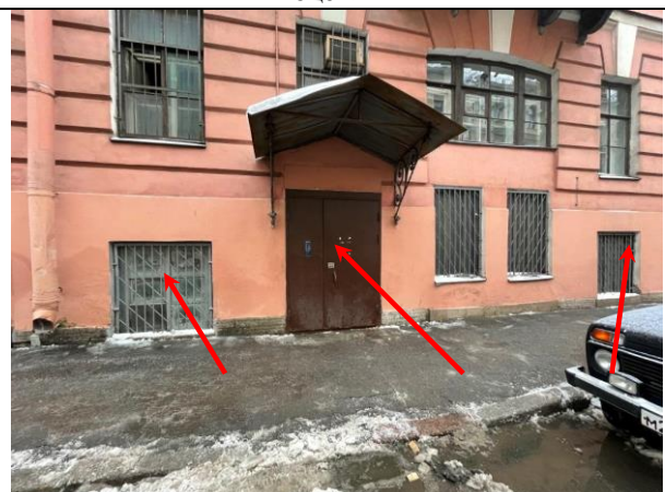
Фото 18. Входная и оконная группа Объекта оценки
