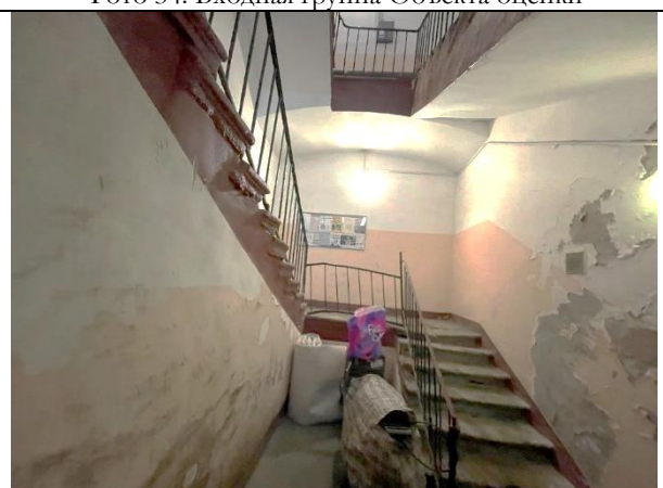
Фото 36. Лестничный проём здания, в котором расположен Объект оценки
