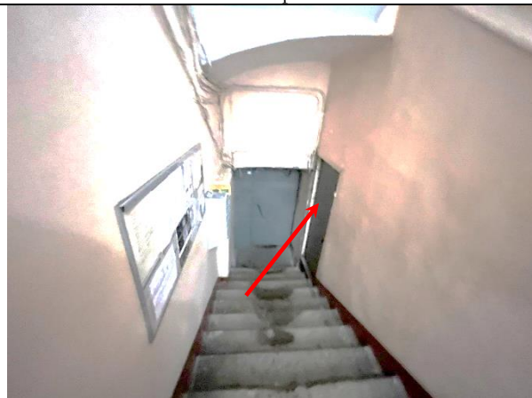
Фото 41. Лестничный проём здания, в котором расположен Объект оценки, входная группа Объекта оценки, пом.2-Н
