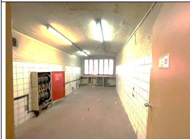
Фото 25. Типичное состояние Объекта оценки
