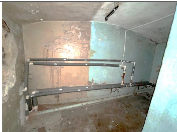
Фото 55. Типичное состояние Объекта оценки
