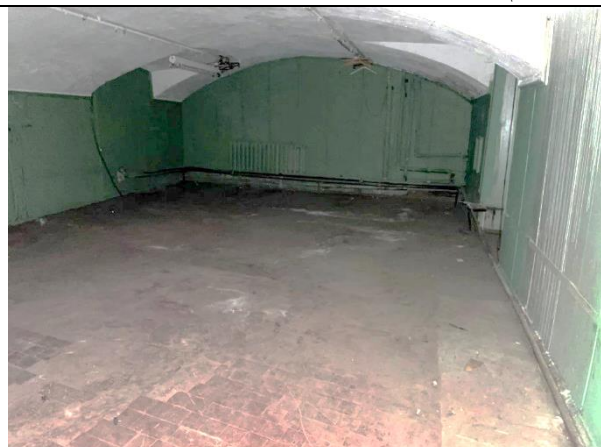
Фото 59. Типичное состояние Объекта оценки
