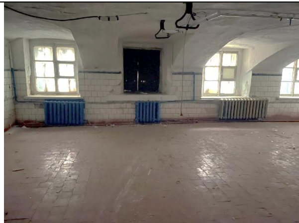
Фото 57. Типичное состояние Объекта оценки
