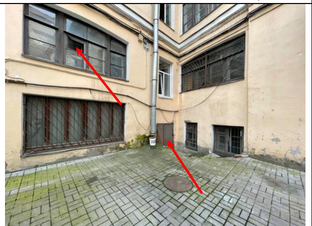
Фото 84. Входная и оконная группа Объекта оценки
