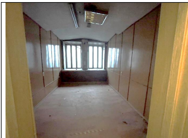
Фото 23. Типичное состояние Объекта оценки
