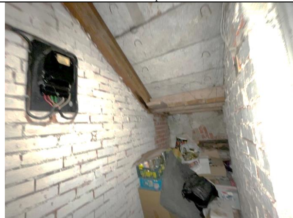
Фото 58. Типичное состояние Объекта оценки
