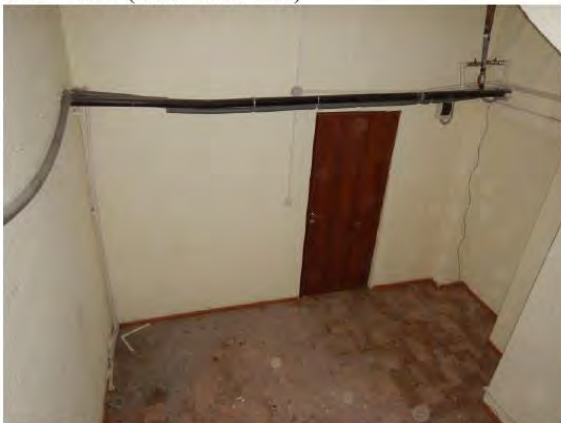
Фото №15 (ч.п.3 пом. 8-Н)
