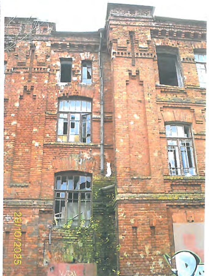
Фото 77. Часть северного фасада
