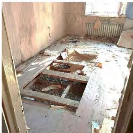
Фото 23. Вид на одно из помещений 3 этажа
