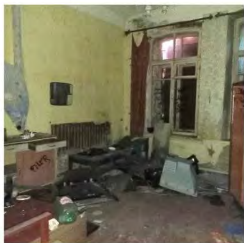
Фото 17. Вид одного из помещений 1-го этажа
