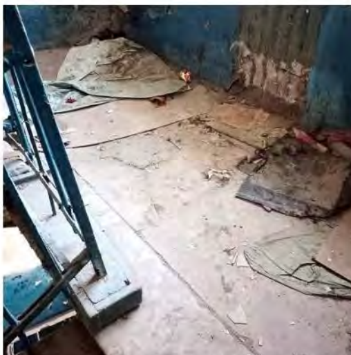
Фото 22. Лестничная площадка м/у 2 и 3 этажами
