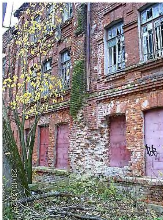
Фото 55. Часть южного фасада
