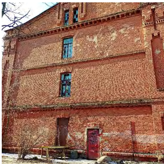
Фото 9. Вид на Вид на часть восточного фасада
