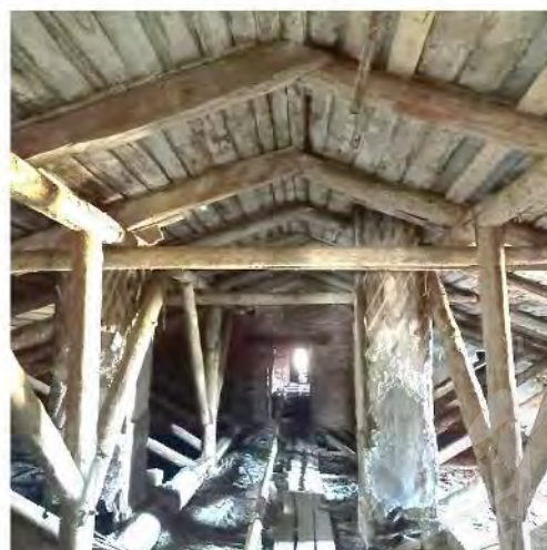
Фото 30. Вид чердачного (подкровельного) пространства и стропильной системы
