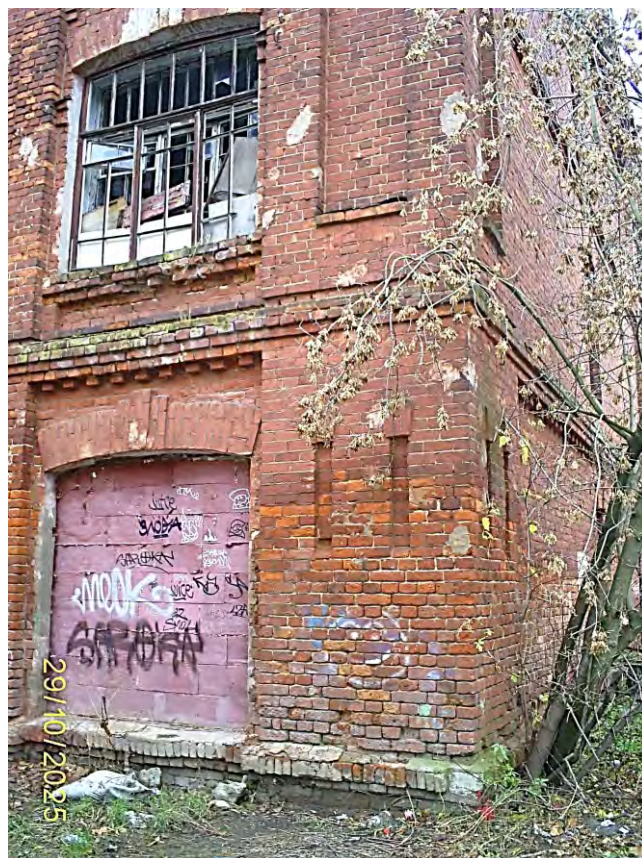
Фото 42. Часть южного фасада
