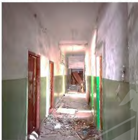
Фото 24. Вид на коридор 3 этажа
