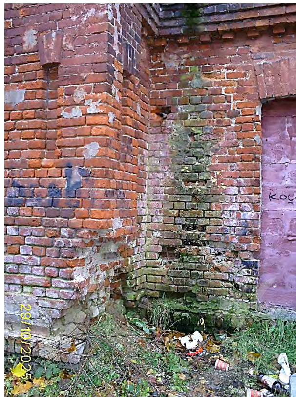
Фото 44. Часть южного фасада
