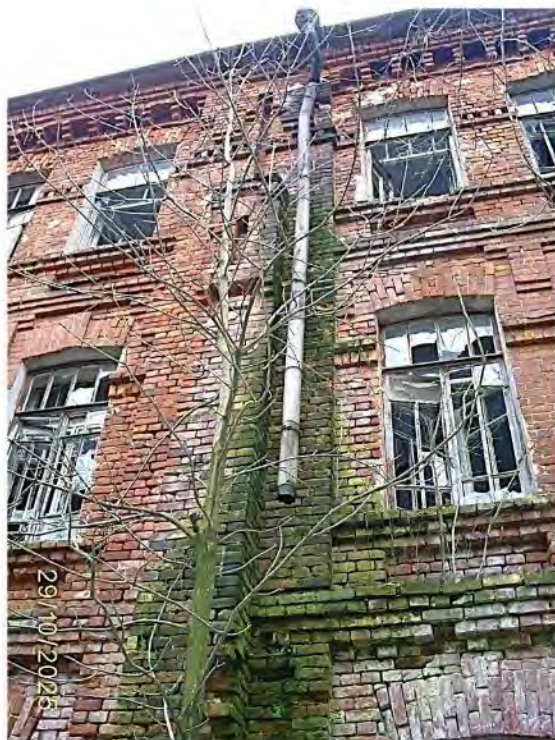
Фото 54. Часть южного фасада
