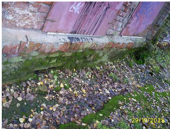
Фото 73. Часть северного фасада
