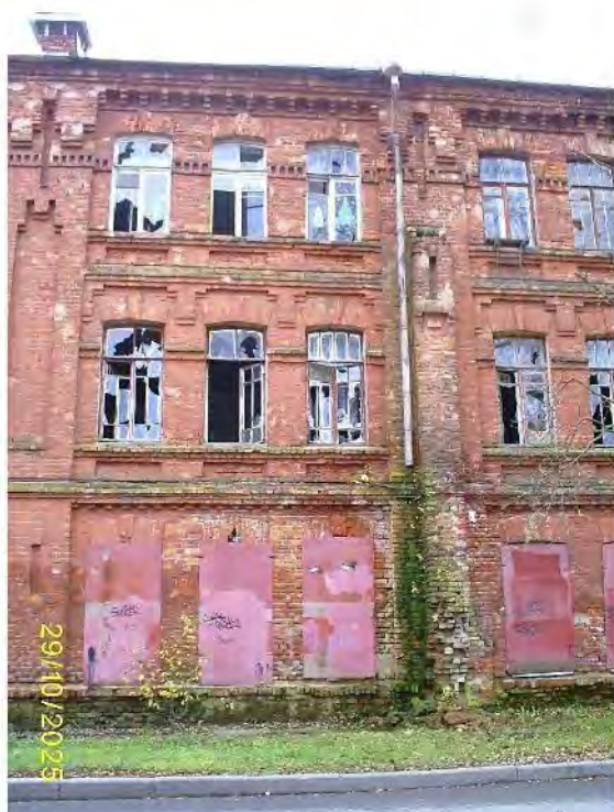
Фото 74. Часть северного фасада
