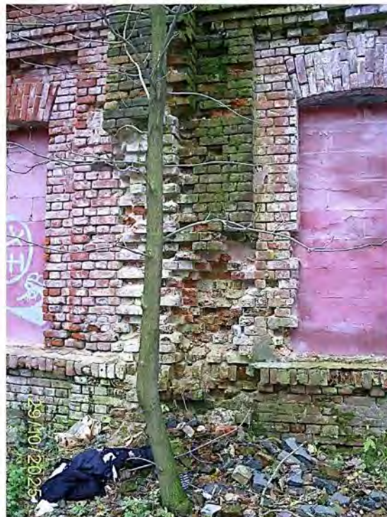
Фото 53. Часть южного фасада
