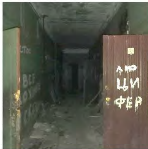
Фото 14. Вид одного из помещений 1-го этажа
