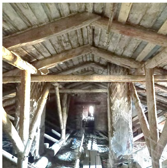
Фото 30. Вид чердачного (подкровельного) пространства и стропильной системы
