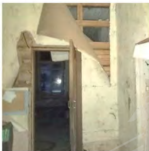
Фото 18. Вид одного из помещений 1-го этажа
