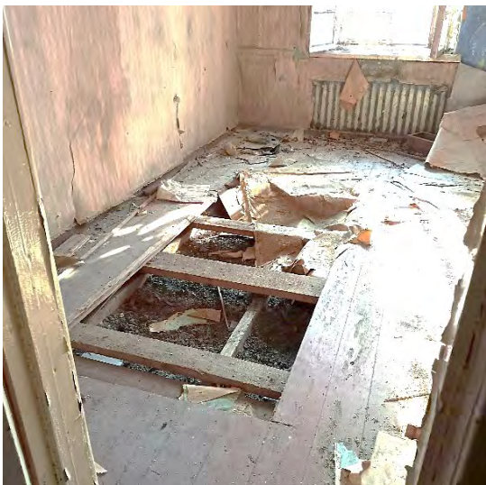
Фото 23. Вид на одно из помещений 3 этажа
