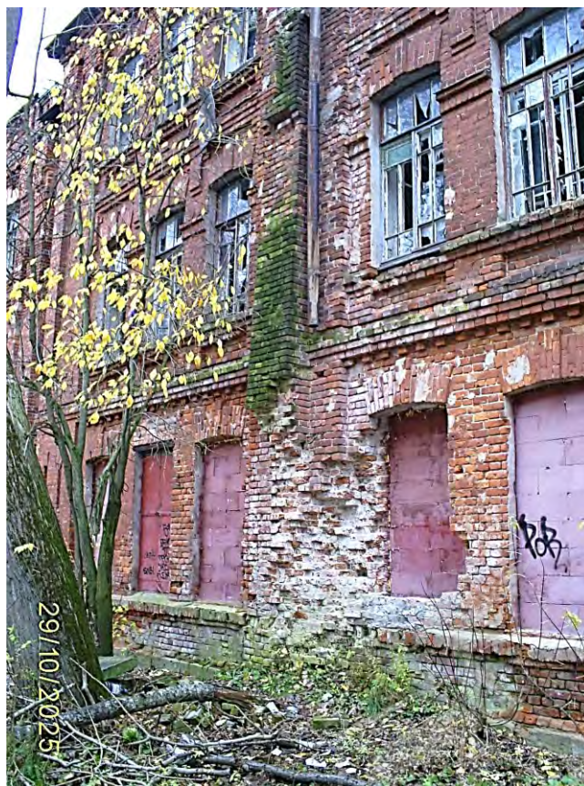
Фото 55. Часть южного фасада
