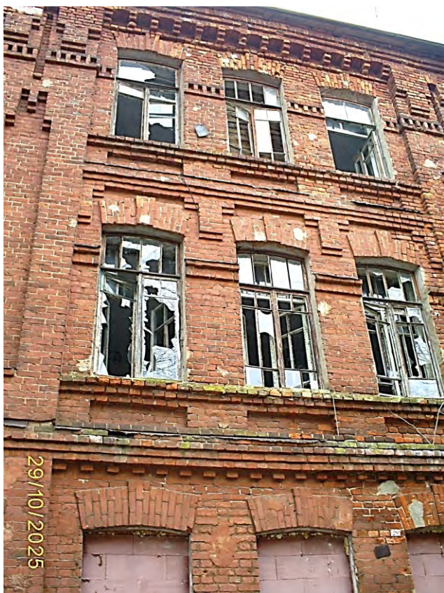
Фото 56. Часть южного фасада
