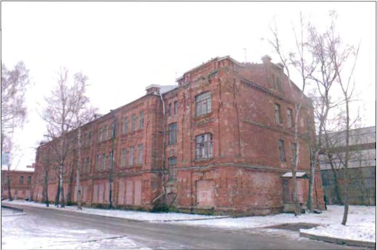
2. Общий вид с северо-запада.
