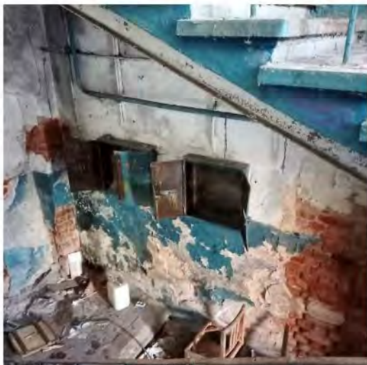
Фото 19. Вид с лестничного марша 1ЛК на 1 этаж
