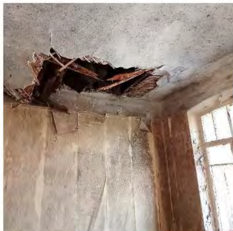
Фото 25. Вид на одно из помещений 3 этажа
