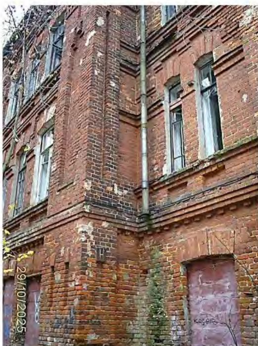
Фото 43. Часть южного фасада
