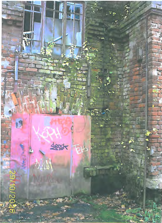
Фото 76. Часть северного фасада со входом ч.п.1 (тамбур) пом. 1ЛК
