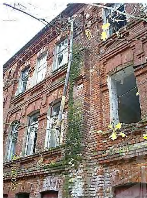
Фото 47. Часть южного фасада
