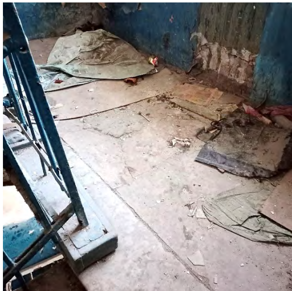
Фото 22. Лестничная площадка м/у 2 и 3 этажами
