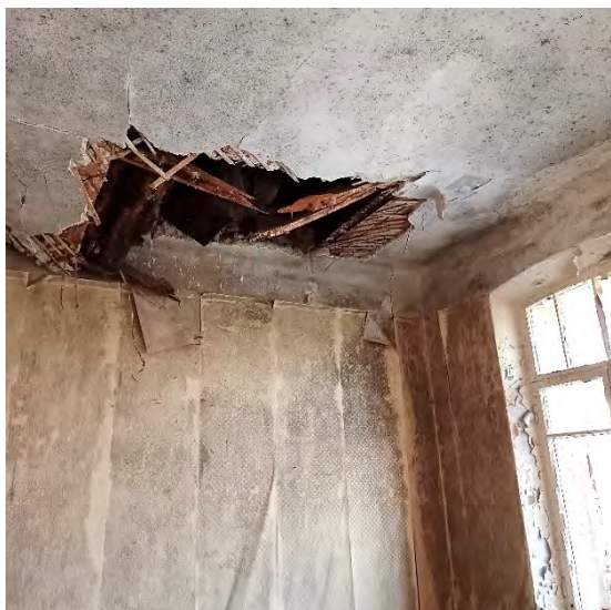
Фото 25. Вид на одно из помещений 3 этажа
