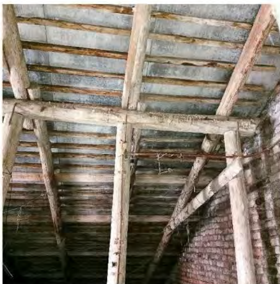
Фото 33. Вид чердачного (подкровельного) пространства и стропильной системы
