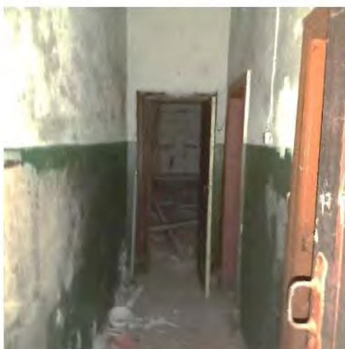
Фото 15. Вид одного из помещений 1-го этажа
