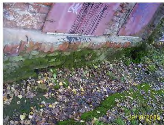
Фото 73. Часть северного фасада
