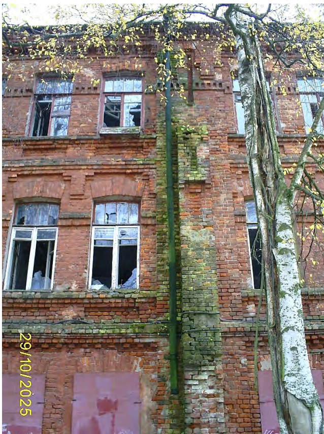
Фото 72. Часть северного фасада
