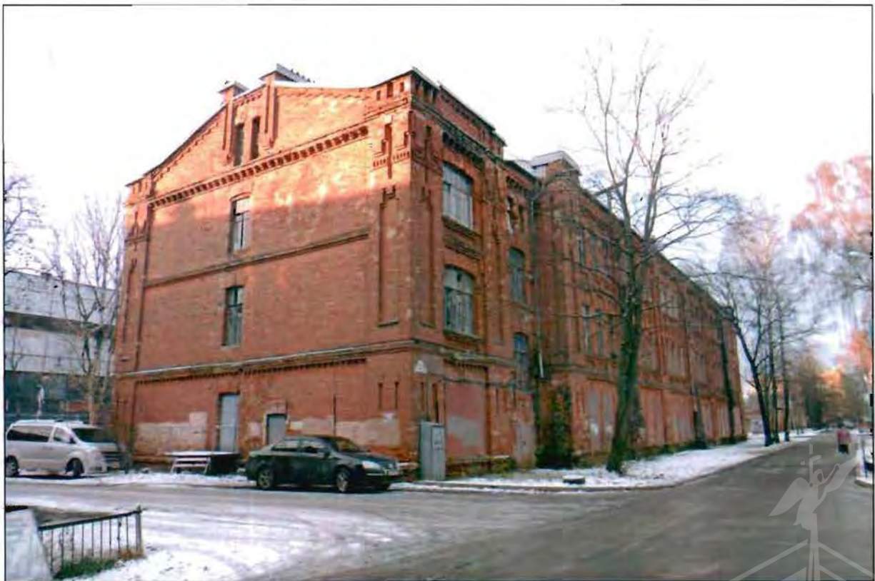
3. Общий вид с северо-востока.
