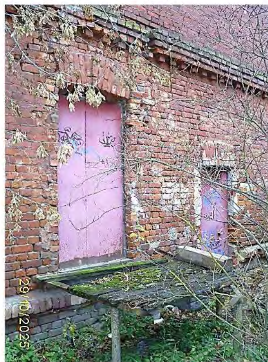
Фото 40. Часть восточного фасада со входами в ч.п.4 (коридор) и ч.п.1 (тамбур) пом. 1-Н
