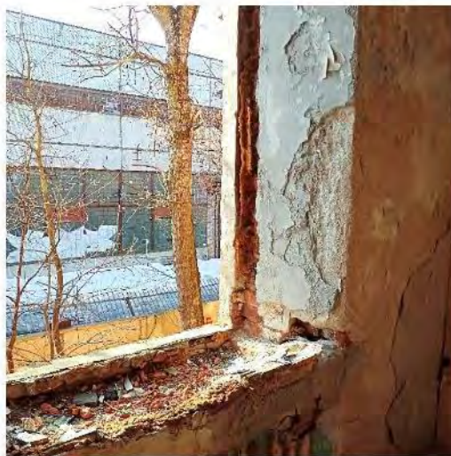
Фото 20. Один из оконных проемов на 2 этаже
