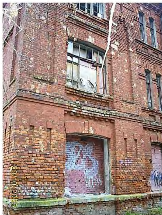
Фото 58. Часть южного фасада
