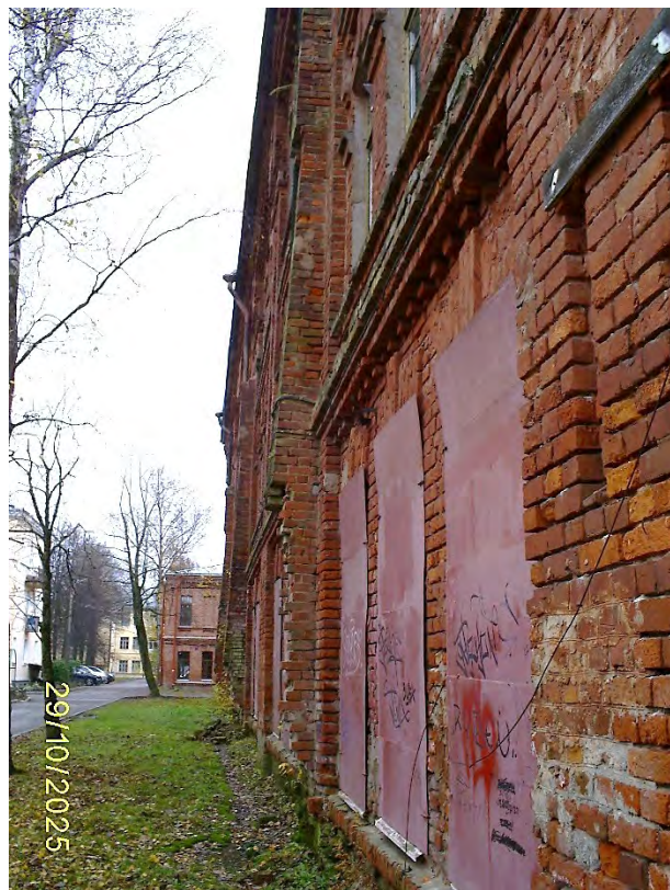
Фото 70. Часть северного фасада
