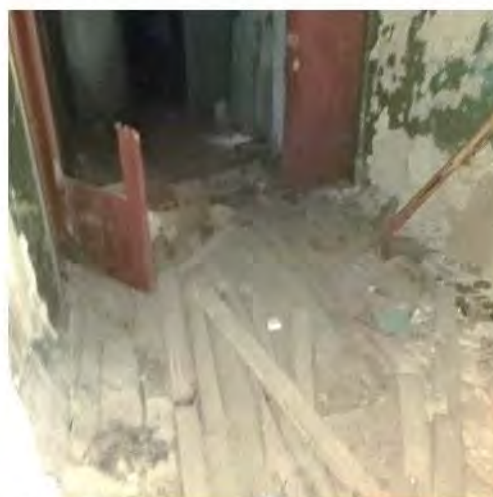
Фото 16. Вид на одно из помещений 1-го этажа
