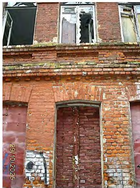
Фото 51. Часть южного фасада
