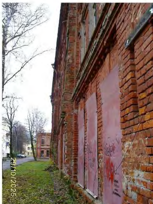
Фото 70. Часть северного фасада
