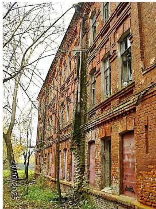
Фото 49. Часть южного фасада
