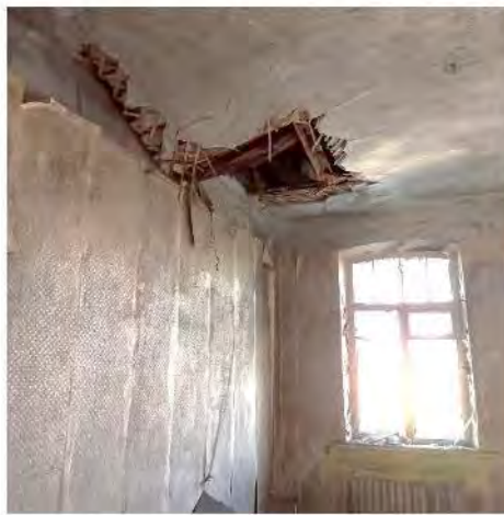
Фото 26. Вид на одно из помещений 3 этажа
