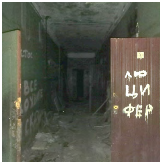
Фото 14. Вид одного из помещений 1-го этажа
