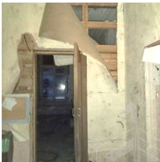
Фото 18. Вид одного из помещений 1-го этажа
