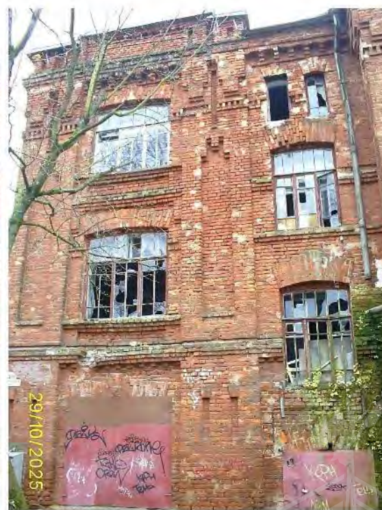
Фото 75. Часть северного фасада
