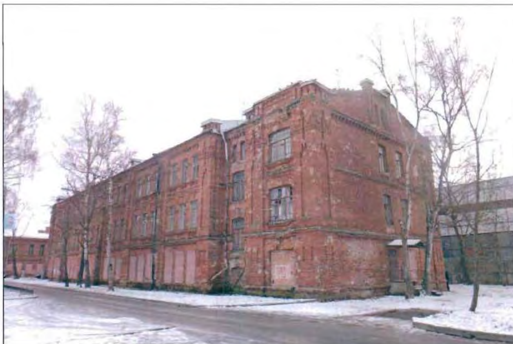
2. Общий вид с северо-запада.
