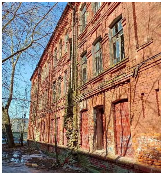
Фото 11. Вид на западную часть южного фасада
