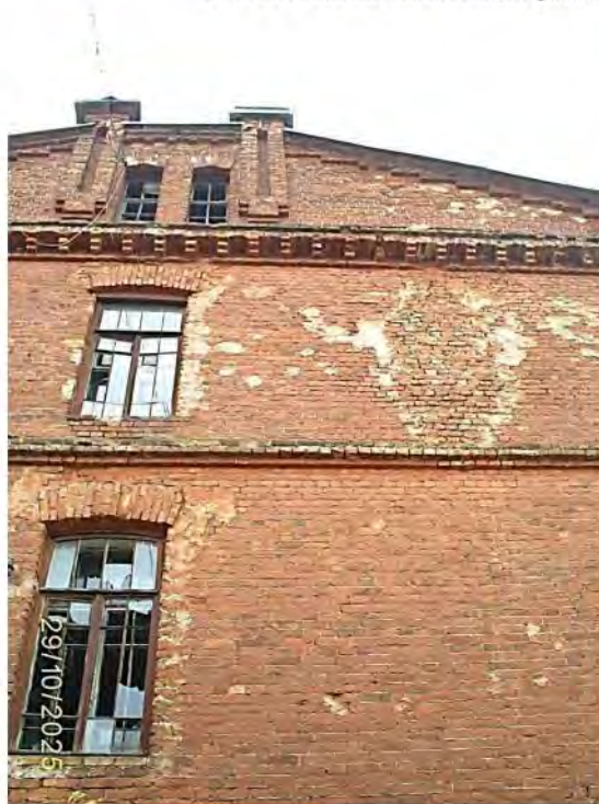
Фото 39. Часть восточного фасада
