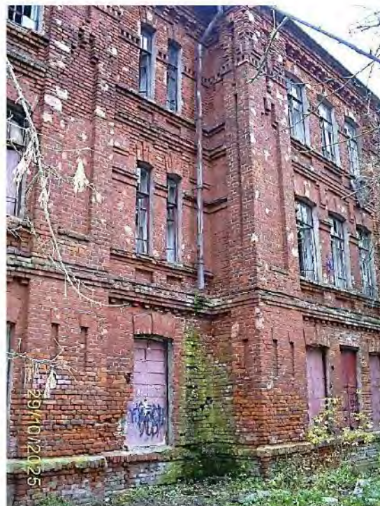
Фото 57. Часть южного фасада
