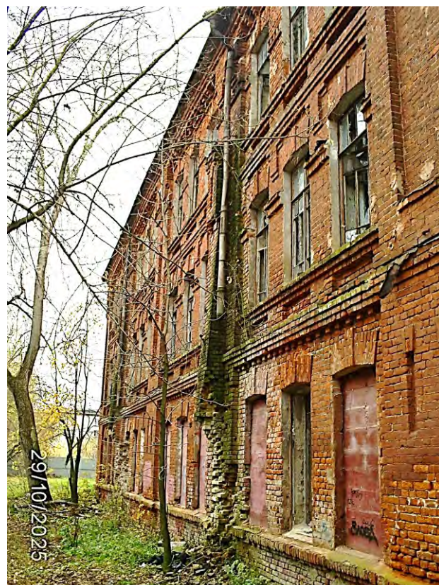
Фото 49. Часть южного фасада
