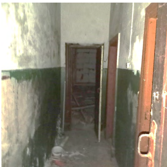
Фото 15. Вид одного из помещений 1-го этажа
