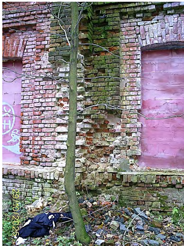
Фото 53. Часть южного фасада
