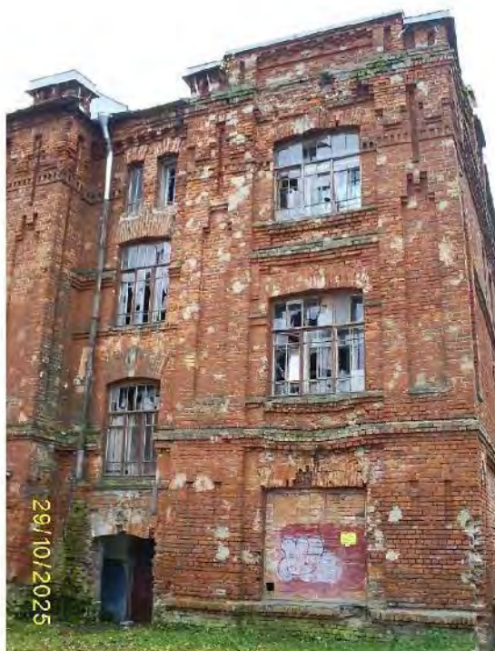
Фото 66. Часть северного фасада
