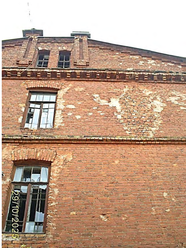
Фото 39. Часть восточного фасада
