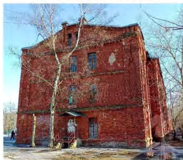
Фото 12. Вид на западный фасад
