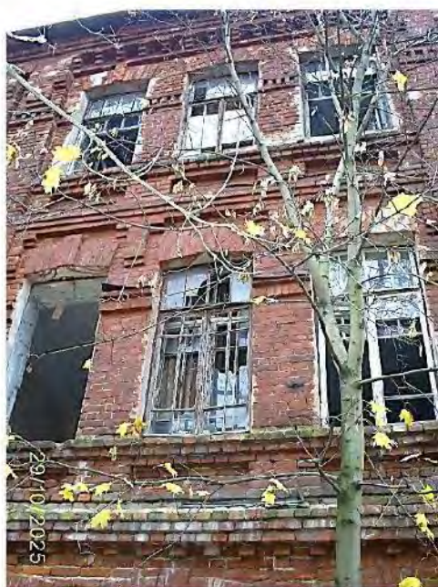
Фото 46. Часть южного фасада
