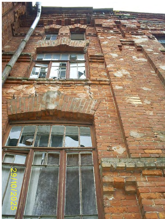
Фото 69. Часть северного фасада
