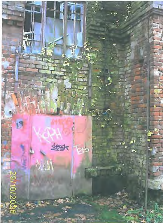
Фото 76. Часть северного фасада со входом ч.п. I (тамбур) пом. 1ЛК
