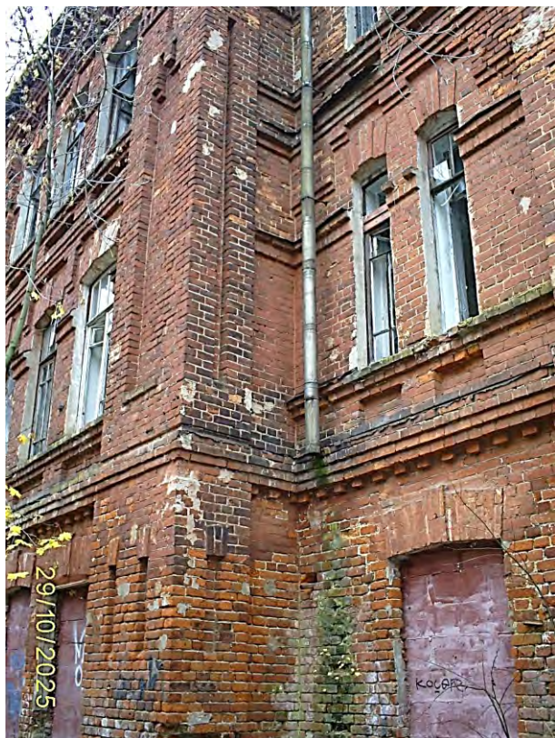
Фото 43. Часть южного фасада
