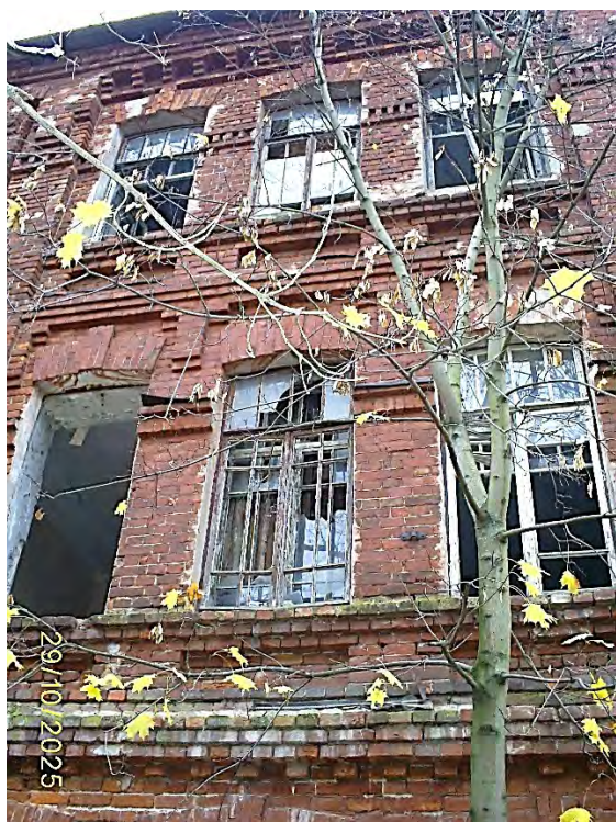
Фото 46. Часть южного фасада
