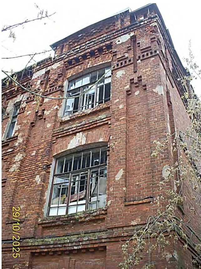
Фото 41. Часть южного фасада
