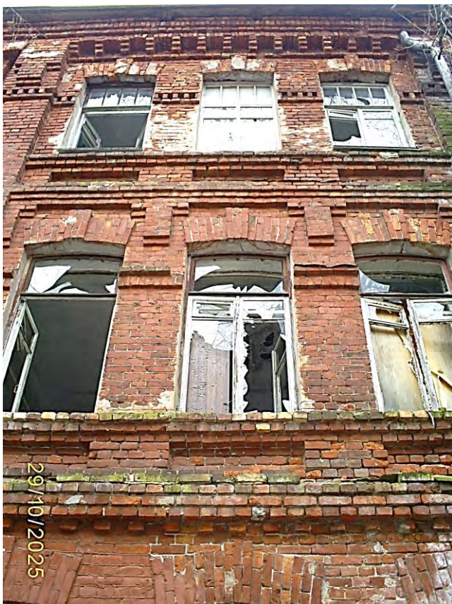
Фото 52. Часть южного фасада
