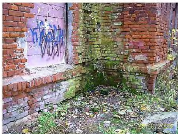
Фото 59. Часть южного фасада
