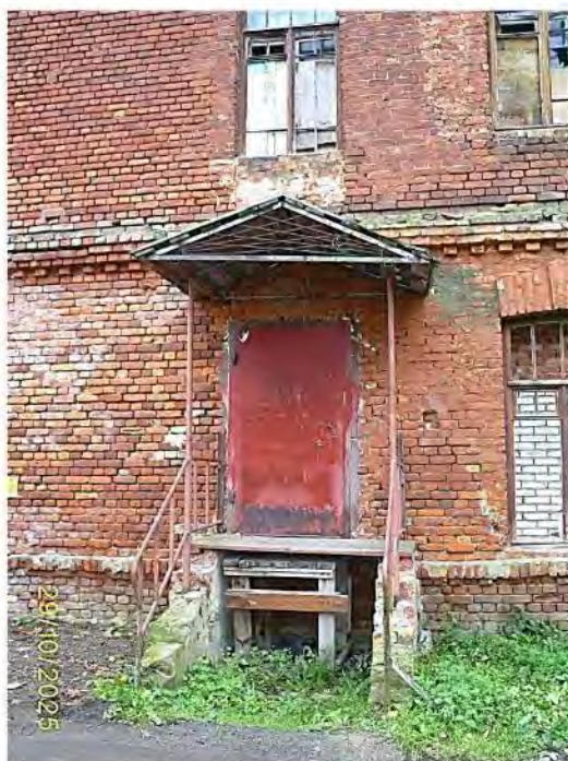
Фото 61. Западный фасад. Вход в ч.п. 14 (коридор) пом. 2-Н)
