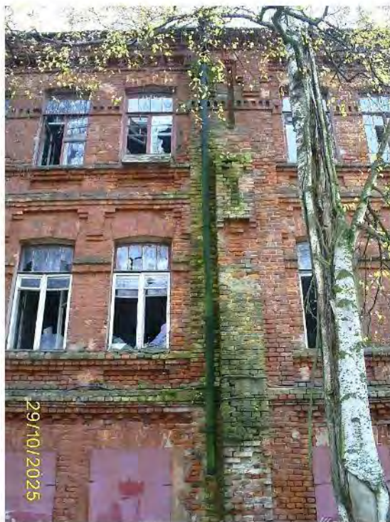
Фото 72. Часть северного фасада
