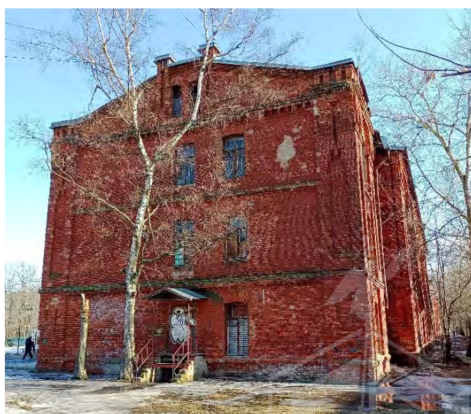
Фото 12. Вид на западный фасад
