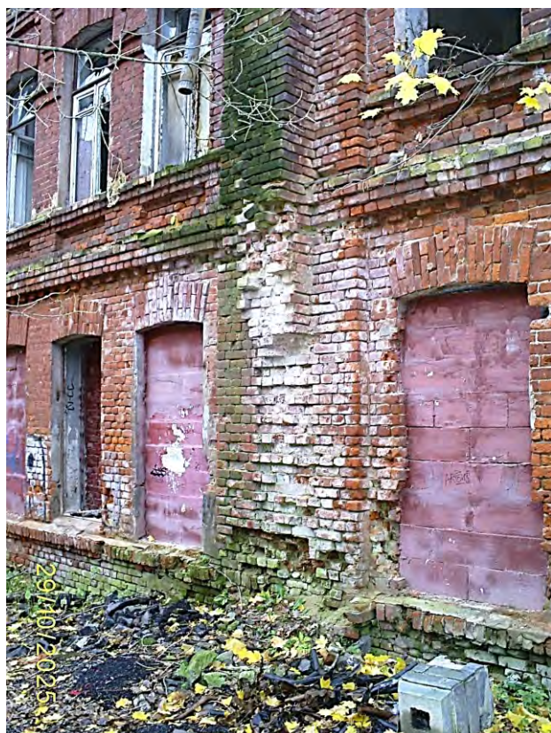
Фото 48. Часть южного фасада
