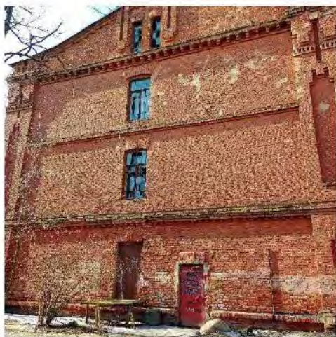
Фото 9. Вид на часть восточного фасада
