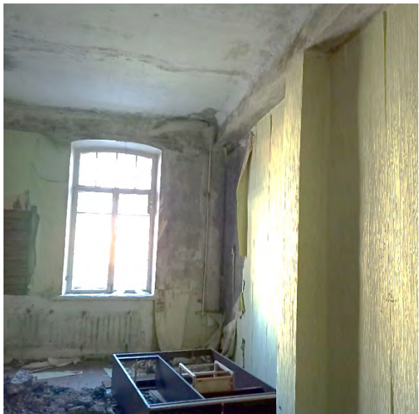
Фото 21. Вид на одно из помещений 2 этажа
