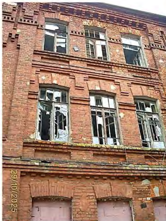
Фото 56. Часть южного фасада
