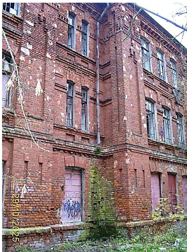
Фото 57. Часть южного фасада
