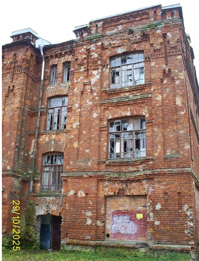
Фото 66. Часть северного фасада
