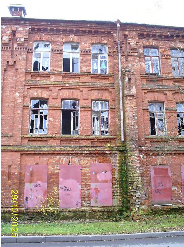
Фото 74. Часть северного фасада
