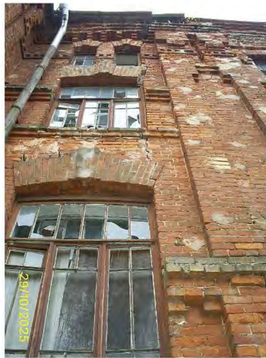
Фото 69. Часть северного фасада
