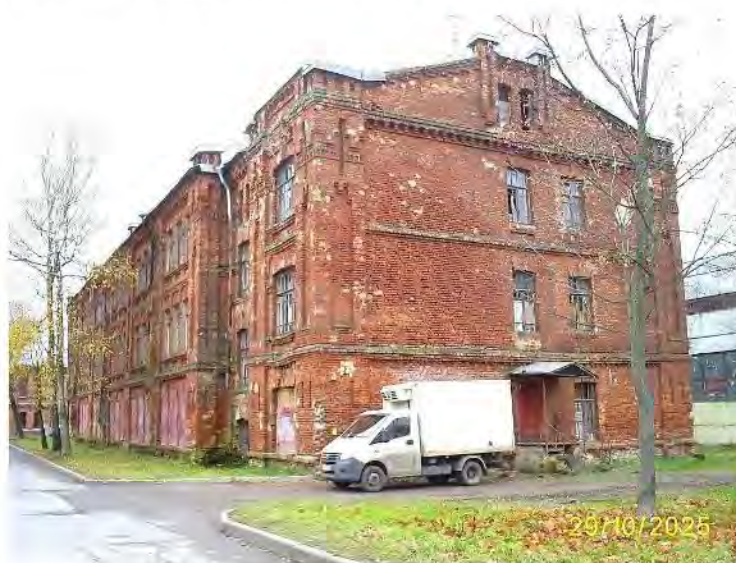
Фото 1. Вид со стороны Санкт-Петербургского шоссе на северо-западный угол Объекта
