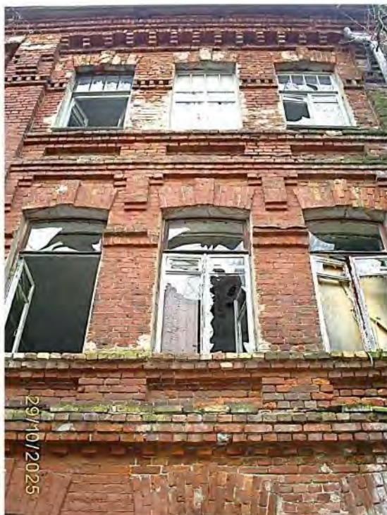
Фото 52. Часть южного фасада
