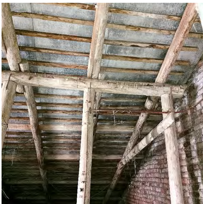
Фото 33. Вид чердачного (подкровельного) пространства и стропильной системы
