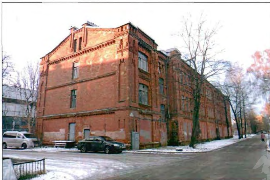
3. Общий вид с северо-востока.
