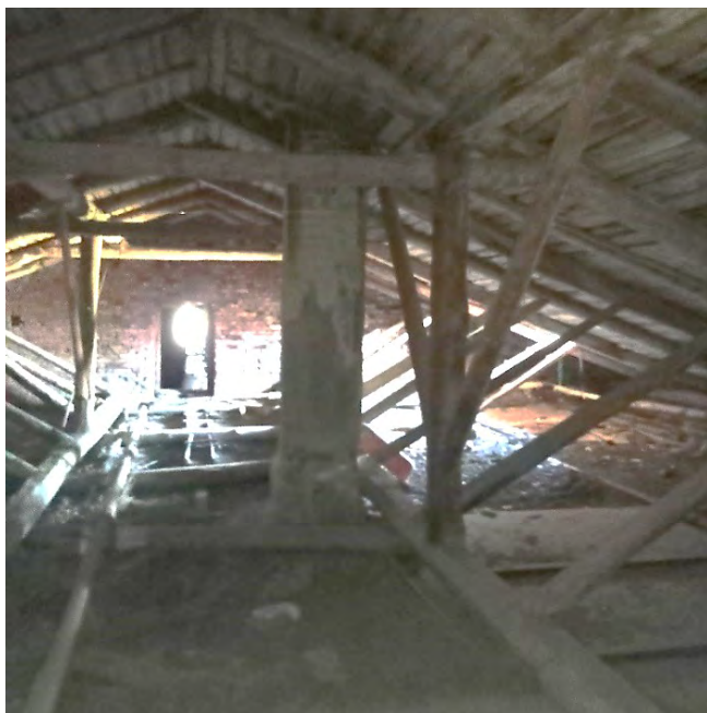
Фото 31. Вид чердачного (подкровельного) пространства и стропильной системы
