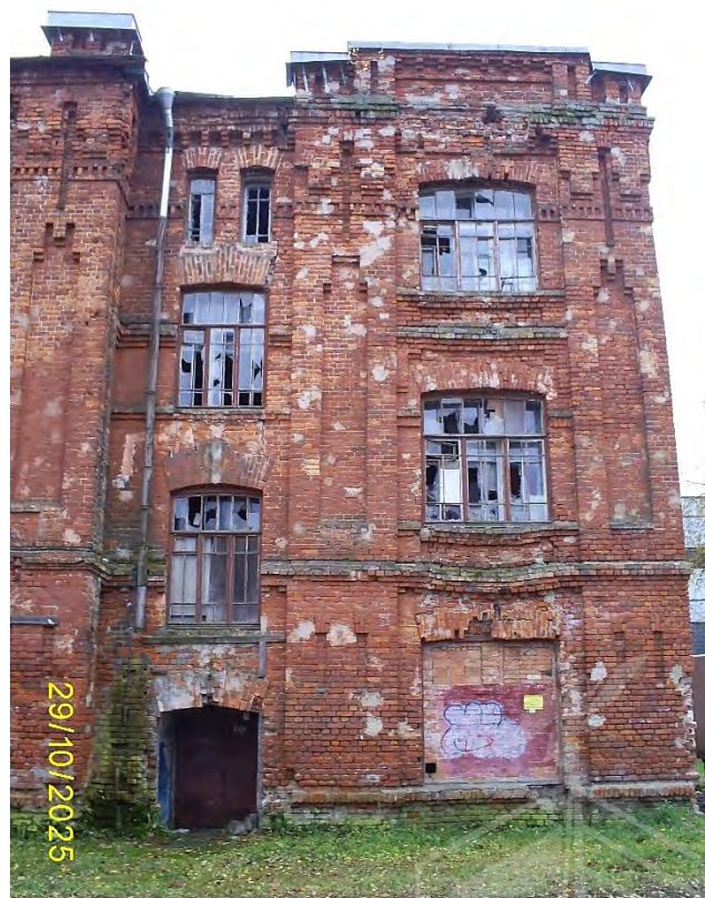
Фото 67. Часть северного фасада со входом ч.п.1 (тамбур) пом. 2ЛК
