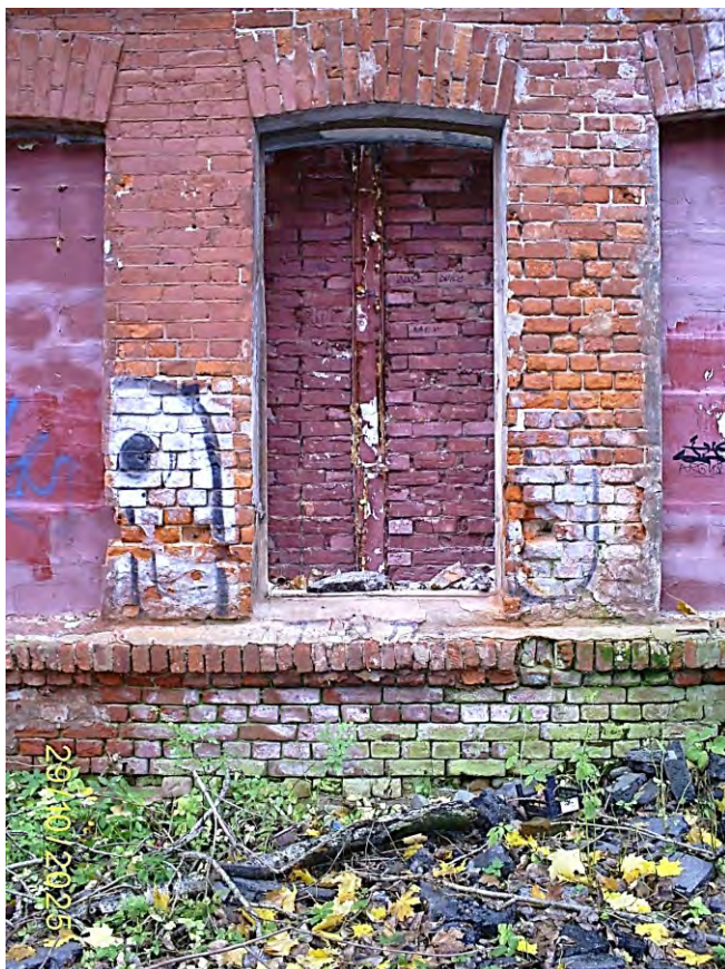
Фото 50. Часть южного фасада
