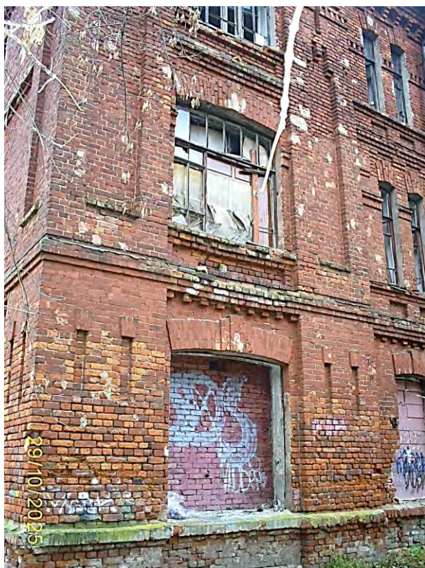
Фото 58. Часть южного фасада
