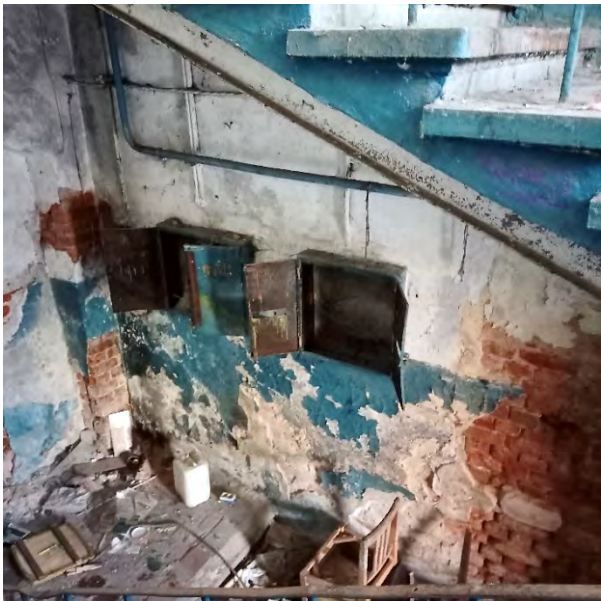
Фото 19. Вид с лестничного марша 1ЛК на 1 этаж
