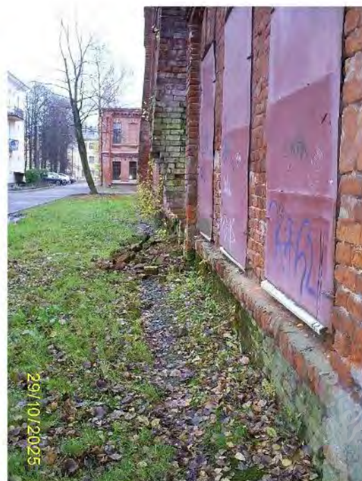
Фото 71. Часть северного фасада
