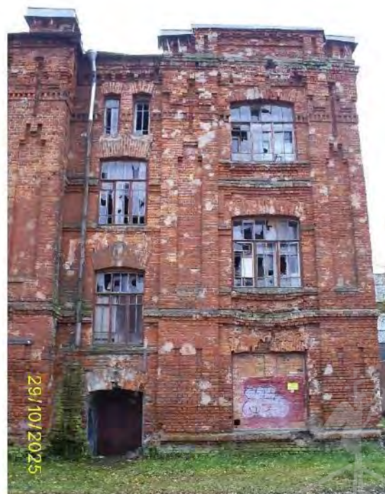
Фото 67. Часть северного фасада со входом ч.п. I (тамбур) пом. 2ЛК
