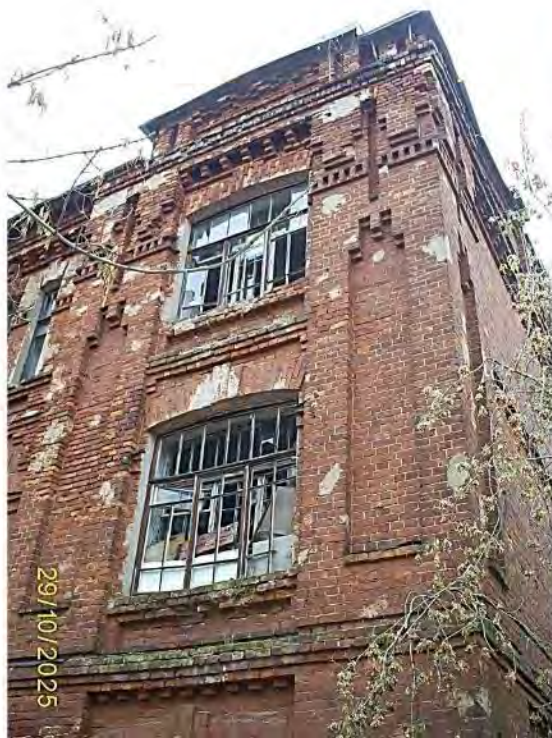
Фото 41. Часть южного фасада
