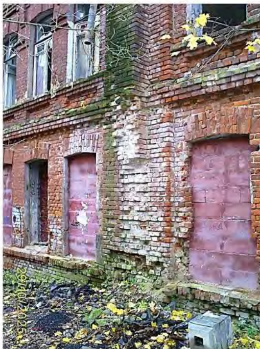
Фото 48. Часть южного фасада
