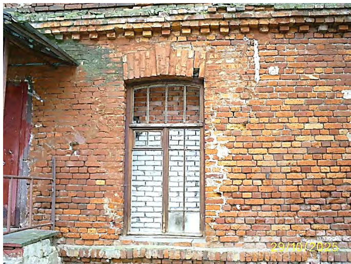
Фото 62. Часть западного фасада
