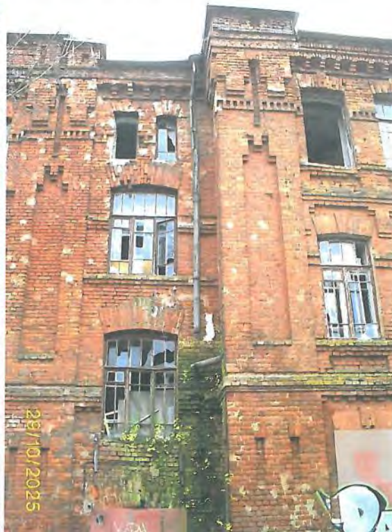
Фото 77. Часть северного фасада
