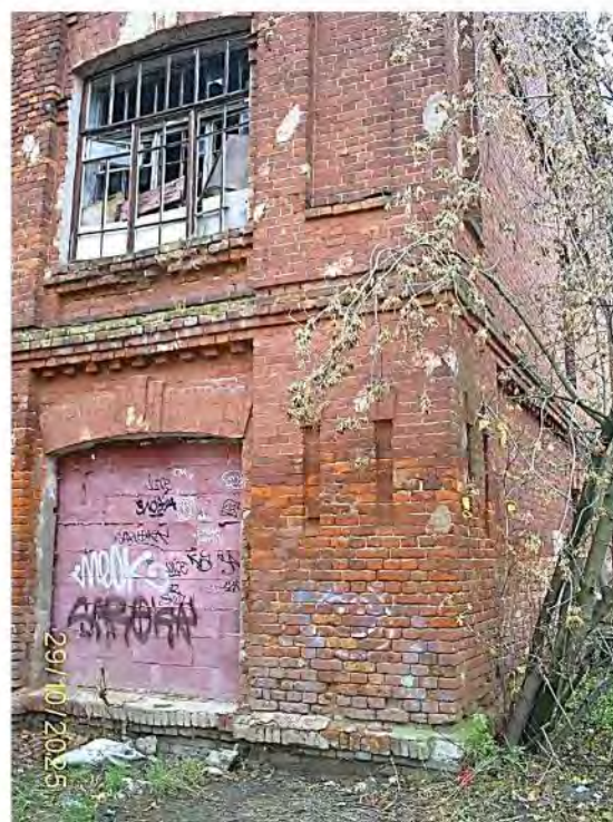
Фото 42. Часть южного фасада
