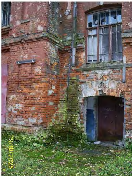
Фото 68. Часть северного фасада со входом ч.п.1 (тамбур) пом. 2ЛК
