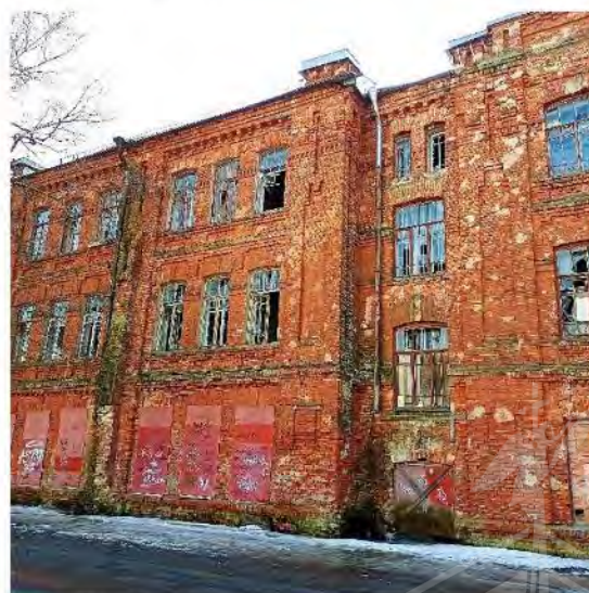
Фото 6. Вид на вход ч.п.1 (тамбур) пом. 2ЛК (западная часть северного фасада)
