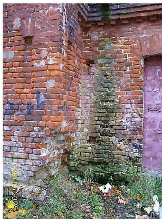
Фото 44. Часть южного фасада
