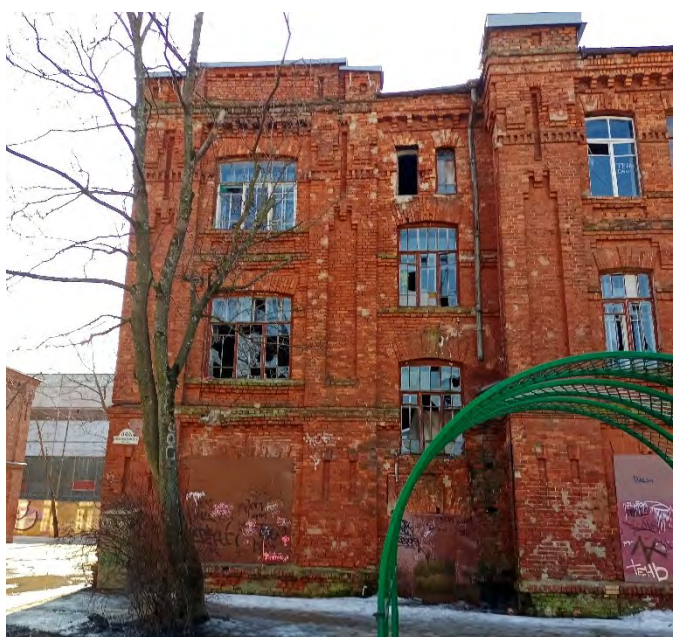
Фото 5. Вид на вход ч/з ч.п.1 (тамбур) пом. 1ЛК (восточная часть северного фасада)
