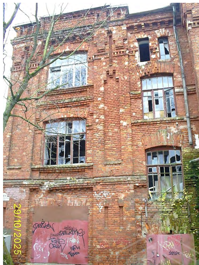
Фото 75. Часть северного фасада
