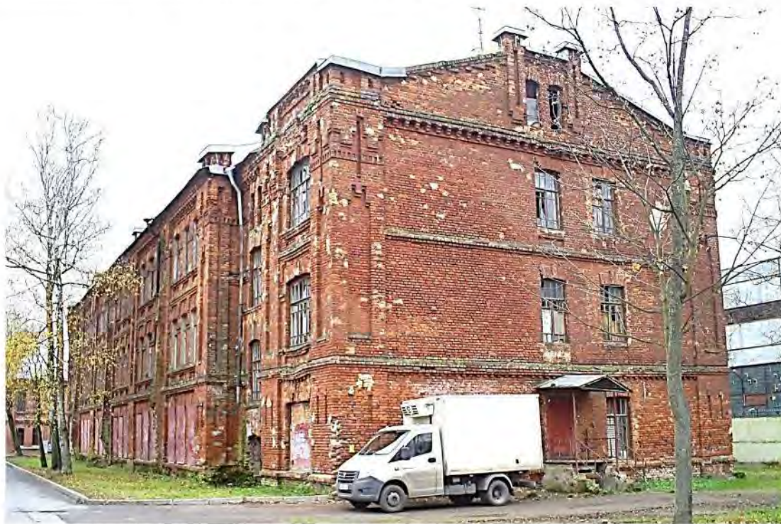
Фото 63. Вид со стороны Санкт-Петербургского шоссе на северо-западный угол Объекта
