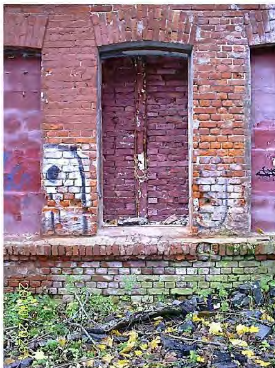
Фото 50. Часть южного фасада
