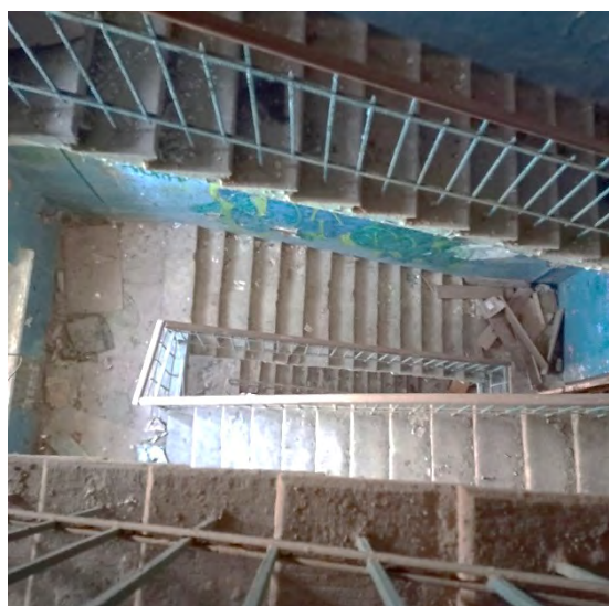
Фото 27. Вид с лестничного марша ЛК м/у 3 этажом и чердаком
