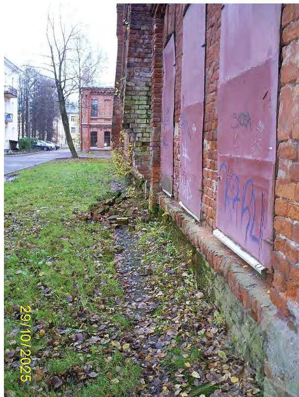
Фото 71. Часть северного фасада
