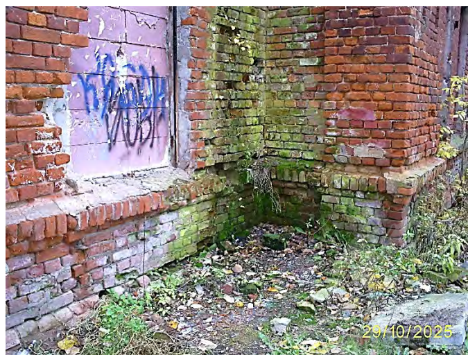
Фото 59. Часть южного фасада
