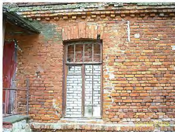
Фото 62. Часть западного фасада
