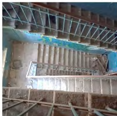
Фото 27. Вид с лестничного марша 1ЛК м/у 3 этажом и чердаком
