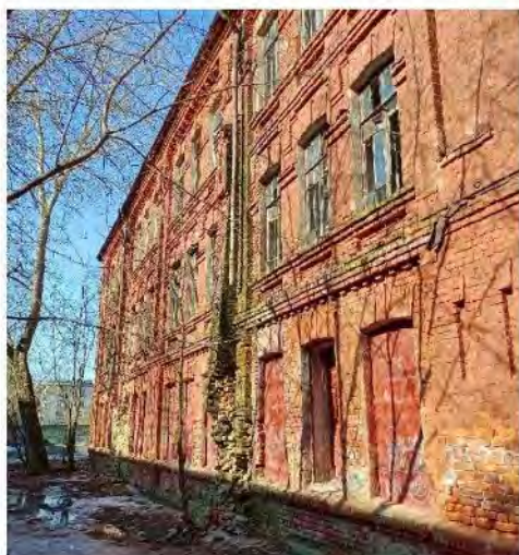
Фото 11. Вид на западную часть южного фасада
