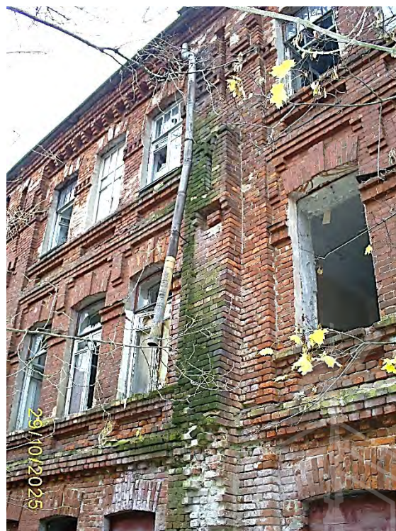
Фото 47. Часть южного фасада
