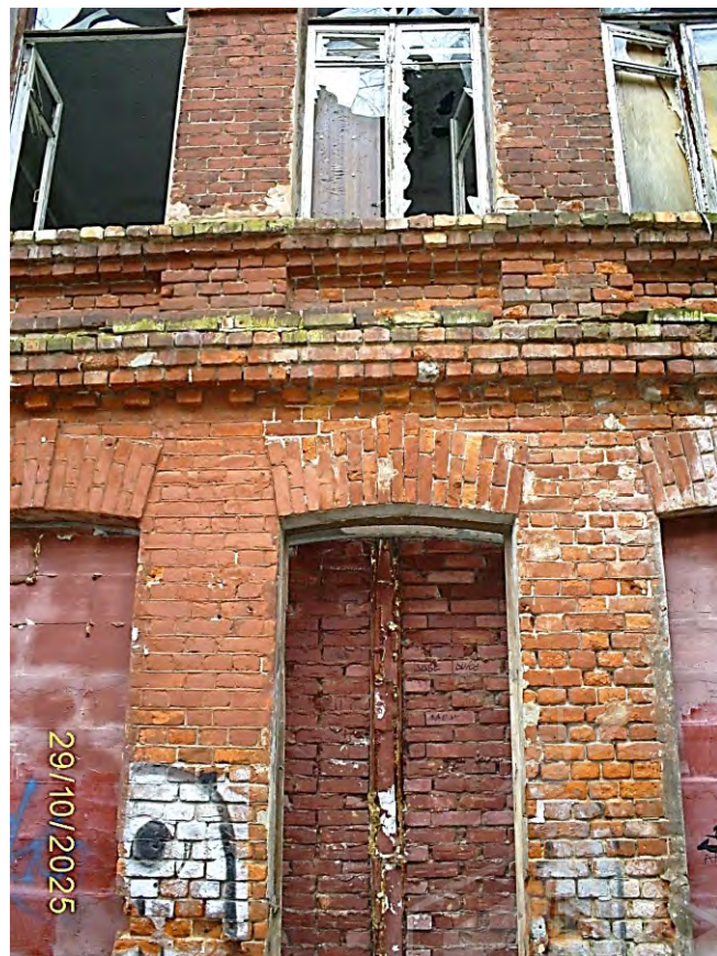
Фото 51. Часть южного фасада
