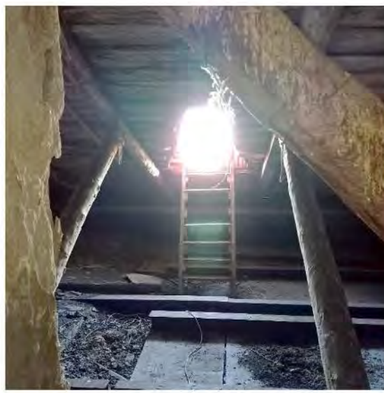
Фото 34. Вид чердачного (подкровельного) пространства и стропильной системы
