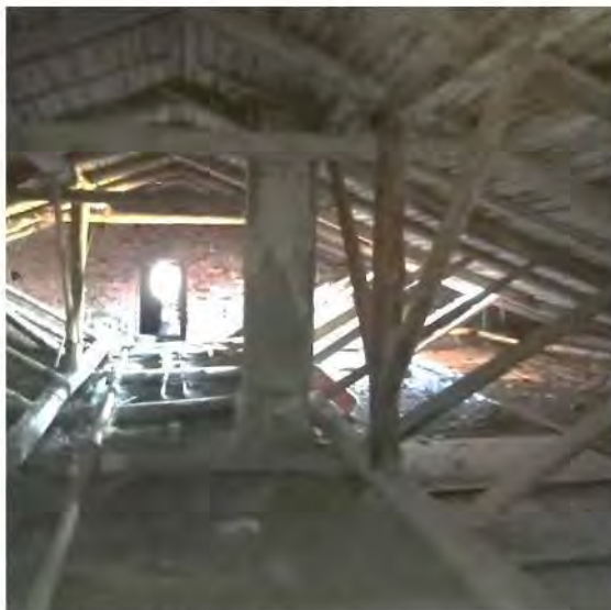
Фото 31. Вид чердачного (подкровельного) пространства и стропильной системы
