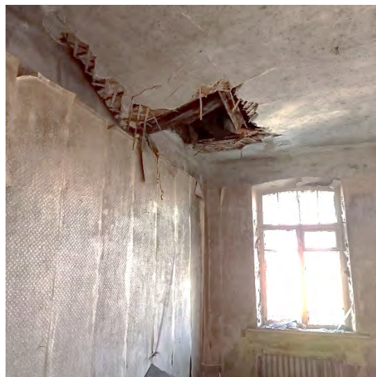
Фото 26. Вид на одно из помещений 3 этажа
