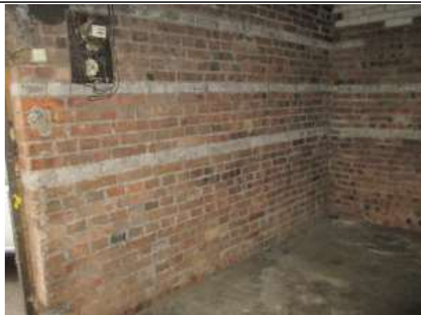
Фото № 18. Внутреннее состояние здания
