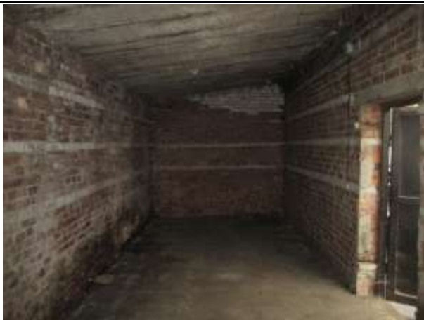
Фото № 11. Внутреннее состояние здания
