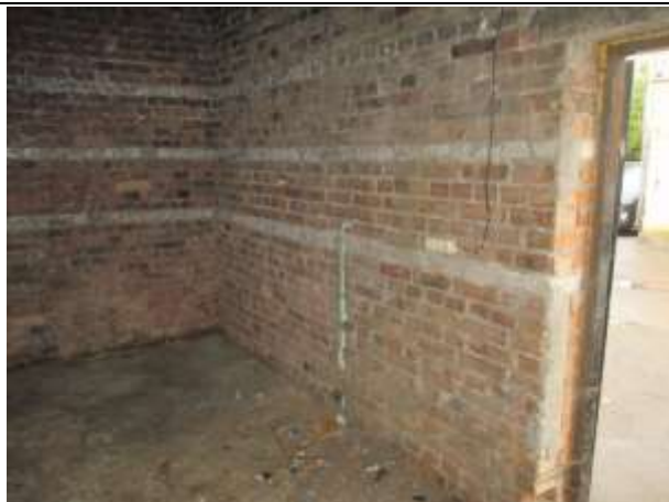
Фото № 17. Внутреннее состояние здания
