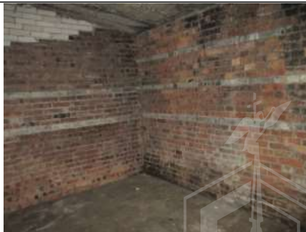
Фото № 14. Внутреннее состояние здания
