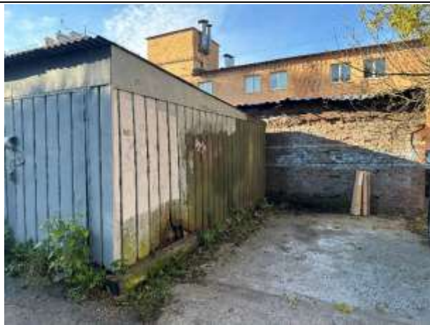
Фото № 5. Внешний вид здания
