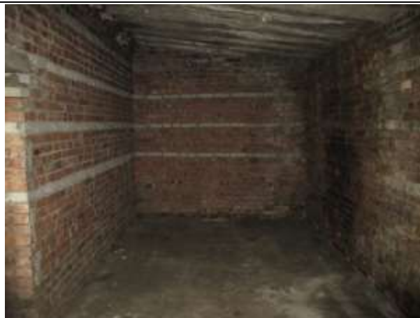
Фото № 12. Внутреннее состояние здания
