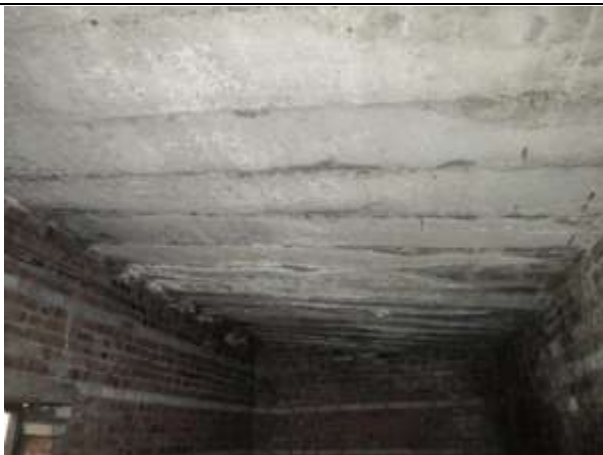
Фото № 13. Внутреннее состояние здания
