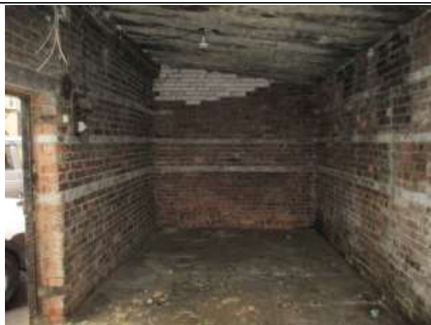
Фото № 16. Внутреннее состояние здания
