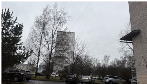
Фото 3. Вид здания Объекта оценки. Дворовая территория
