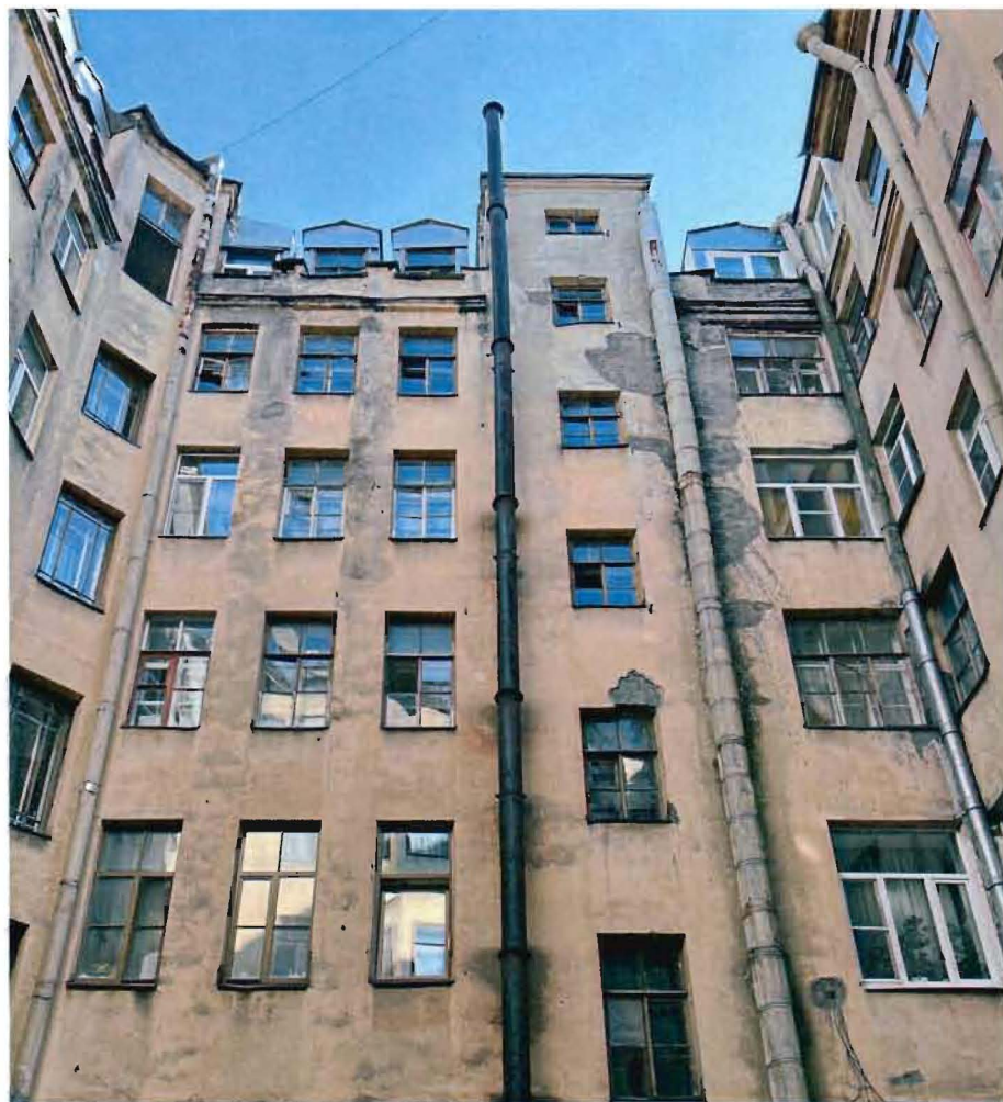
4. Дворовые фасады объекта культурного наследия.
