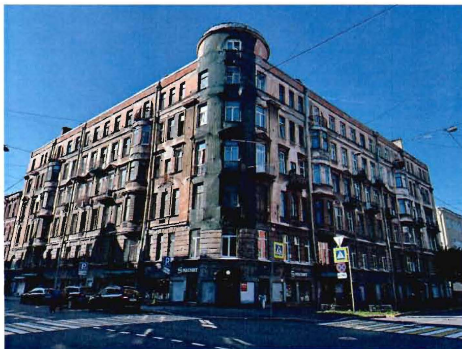
1. Общий вид на объект культурного наследия.
