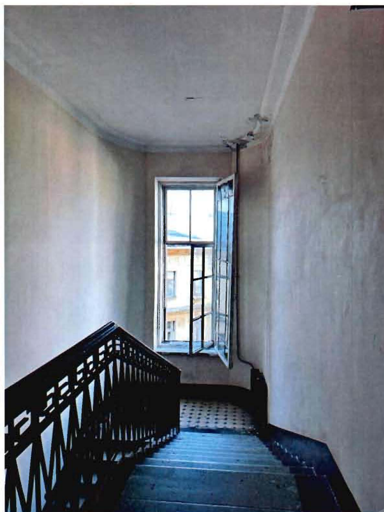
8. Лестница 2ЛК объекта культурного наследия.
