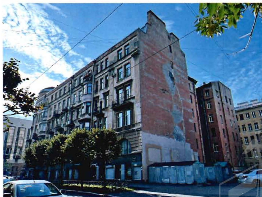
2. Общий вид на объект культурного наследия.
