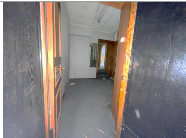
Фото 72. Типичное состояние Объекта оценки
