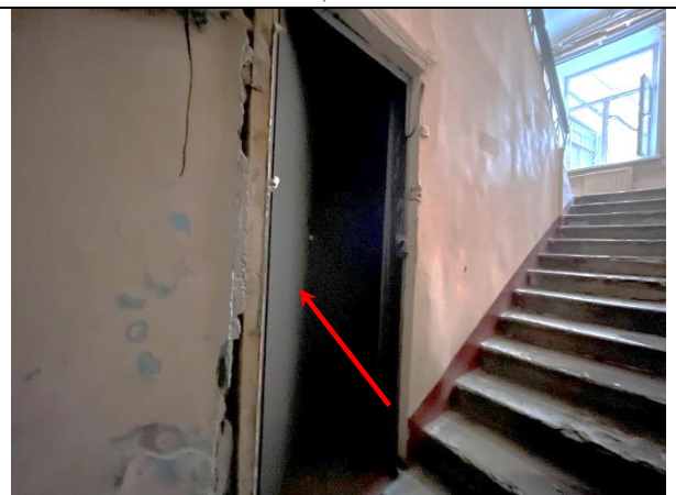
Фото 42. Лестничный проём здания, в котором расположен Объект оценки, входная группа Объекта оценки, пом.2-Н
