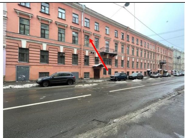
Фото 16. Вид здания, в котором расположен Объект оценки
