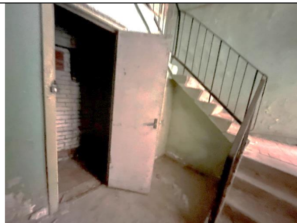
Фото 56. Лестничный проём Объекта оценки
