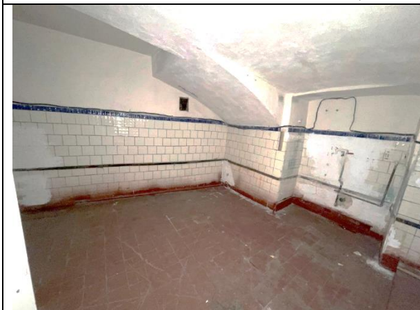
Фото 49. Типичное состояние Объекта оценки
