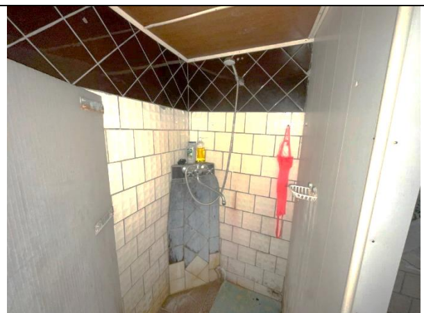
Фото 32. Типичное состояние Объекта оценки
