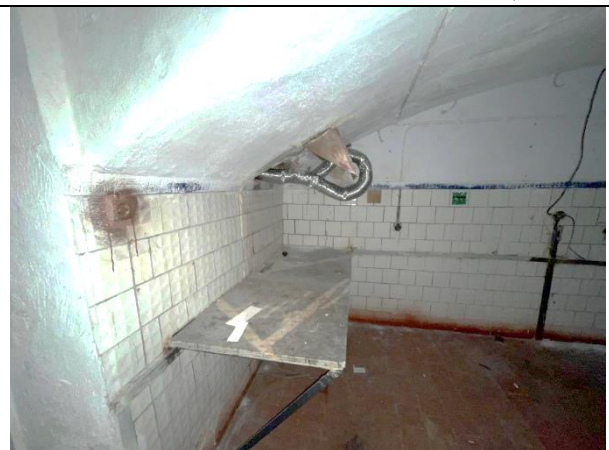
Фото 50. Типичное состояние Объекта оценки
