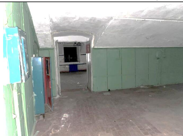
Фото 60. Типичное состояние Объекта оценки
