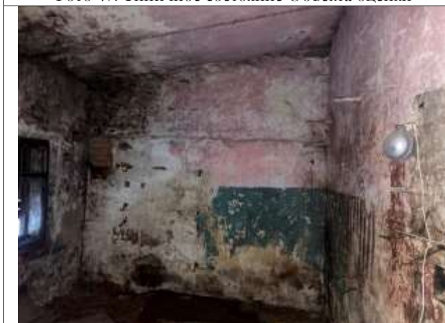
Фото 49. Типичное состояние Объекта оценки
