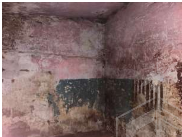
Фото 42. Типичное состояние Объекта оценки
