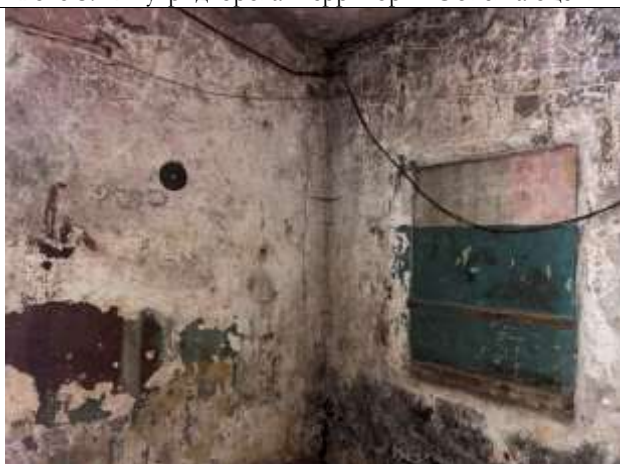
Фото 41. Типичное состояние Объекта оценки
