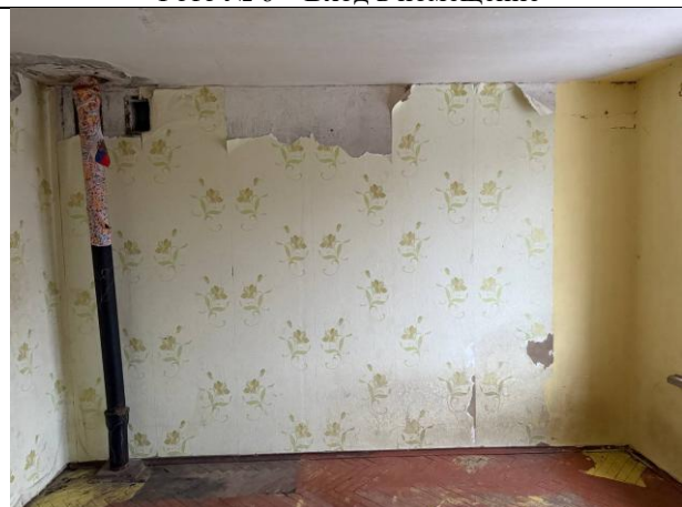
Фото № 8 – Внутреннее состояние помещения
