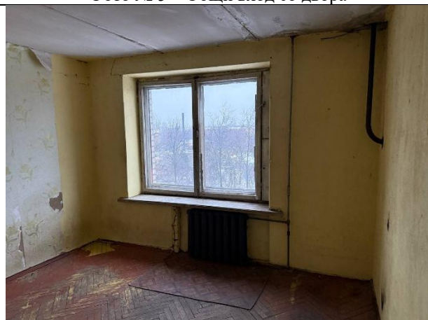
Фото № 7 – Внутреннее состояние помещения
