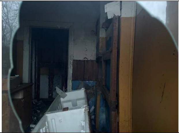
Фото 12. Внутреннее состояние Объекта оценки
