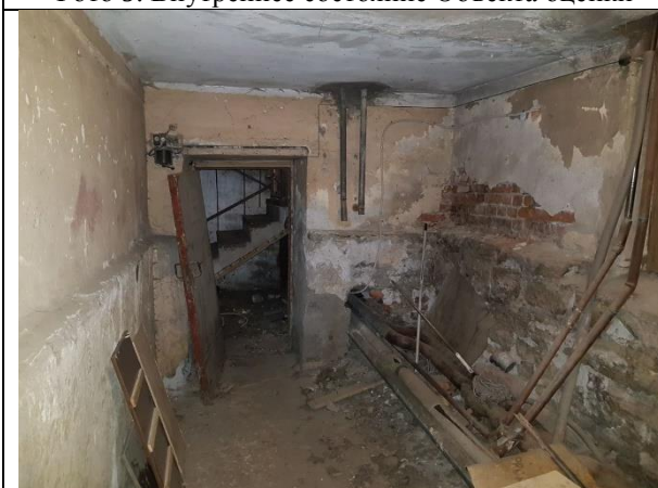
Фото 11. Внутреннее состояние Объекта оценки
