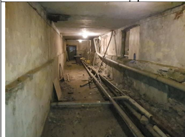
Фото 7. Внутреннее состояние Объекта оценки
