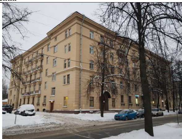
Фото 2. Вид здания, в котором расположен Объект оценки
