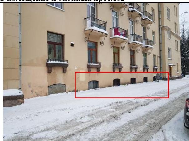
Фото 6. Вид окон Объекта оценки
