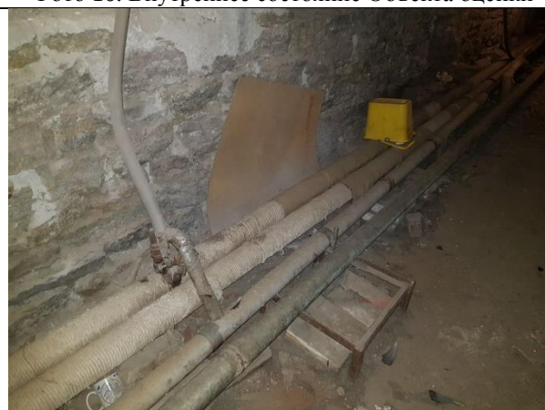
Фото 12. Внутреннее состояние Объекта оценки
