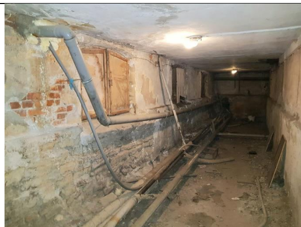
Фото 10. Внутреннее состояние Объекта оценки
