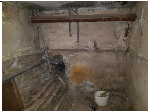
Фото 8. Внутреннее состояние Объекта оценки
