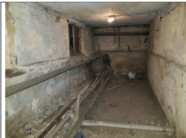
Фото 9. Внутреннее состояние Объекта оценки
