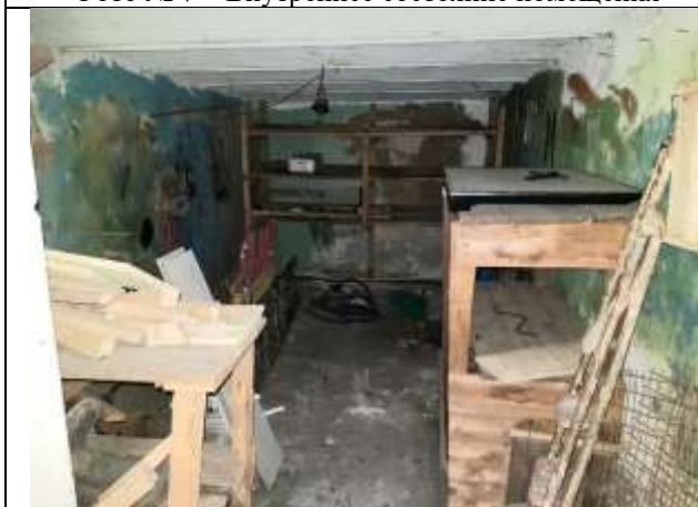
Фото № 9 – Внутреннее состояние помещения
