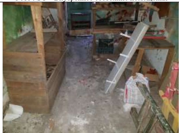
Фото № 10 – Внутреннее состояние помещения
