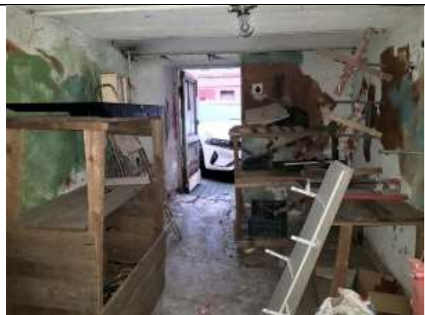
Фото № 8 – Внутреннее состояние помещения
