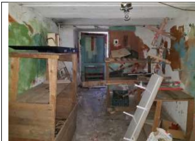
Фото № 7 – Внутреннее состояние помещения
