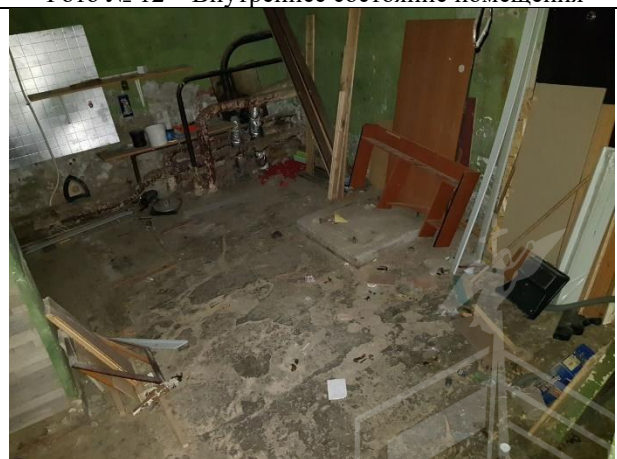
Фото № 14 – Внутреннее состояние помещения
