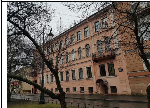
Фото № 3 – Здание, в котором находится Объект оценки
