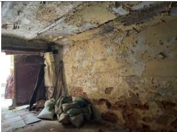
Фото 19. Типичное состояние Объекта оценки
