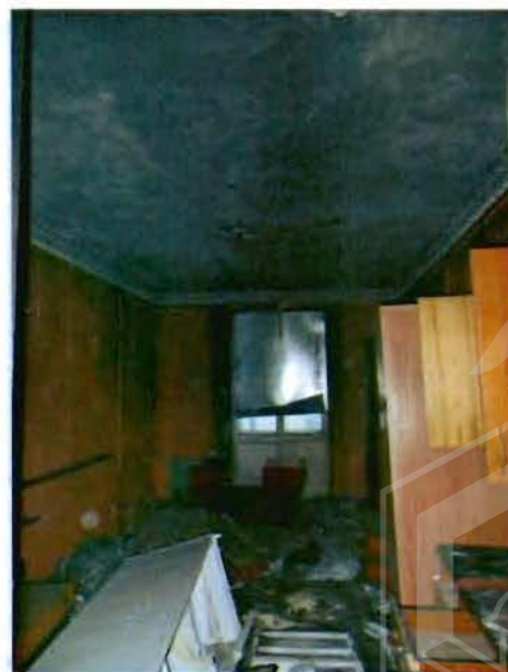
20. Помещение третьего этажа.
