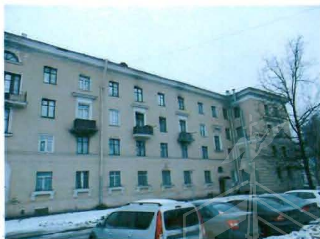
8. Фрагмент фасада. Вид с северо-востока.
