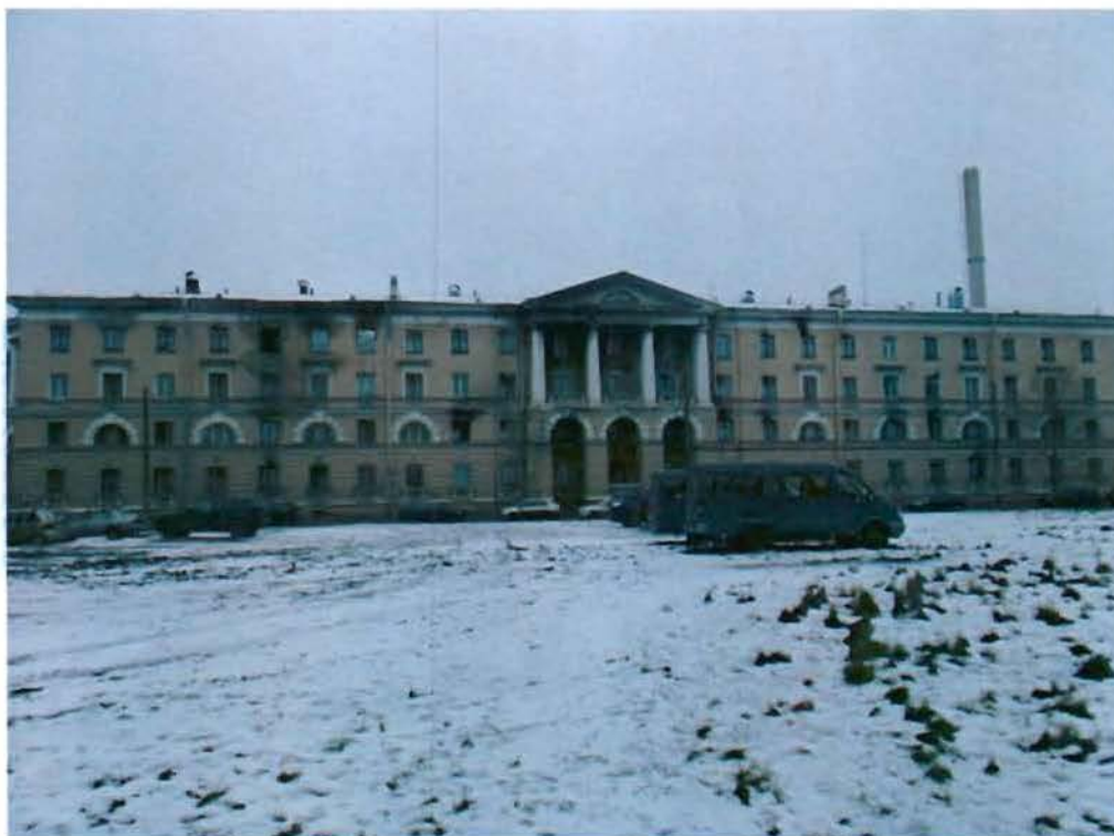
1. Лицевой фасад. Вид с юго-запада.
