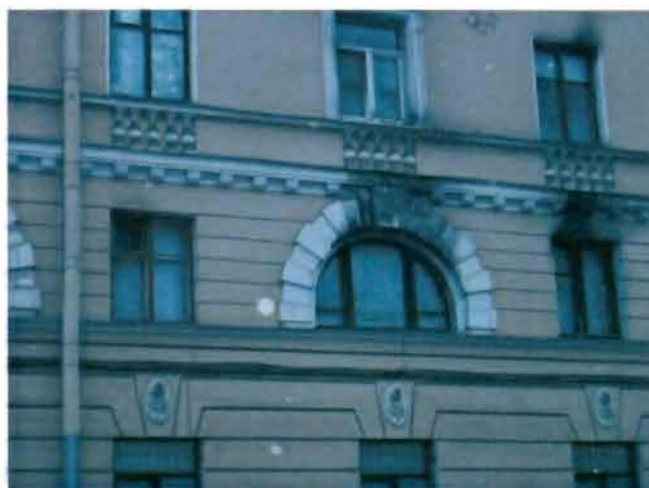
12. Оконные проемы второго этажа.
