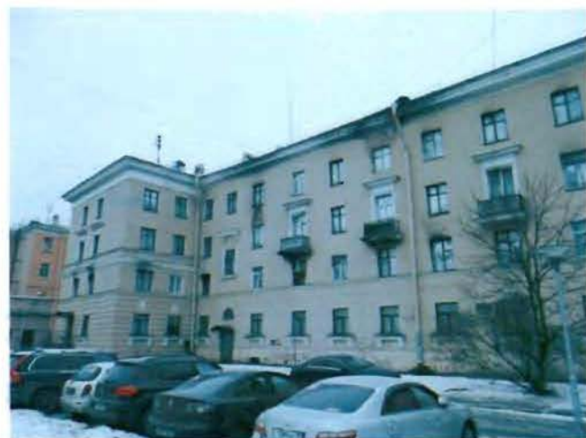
7. Фрагмент фасада. Вид с севера.
