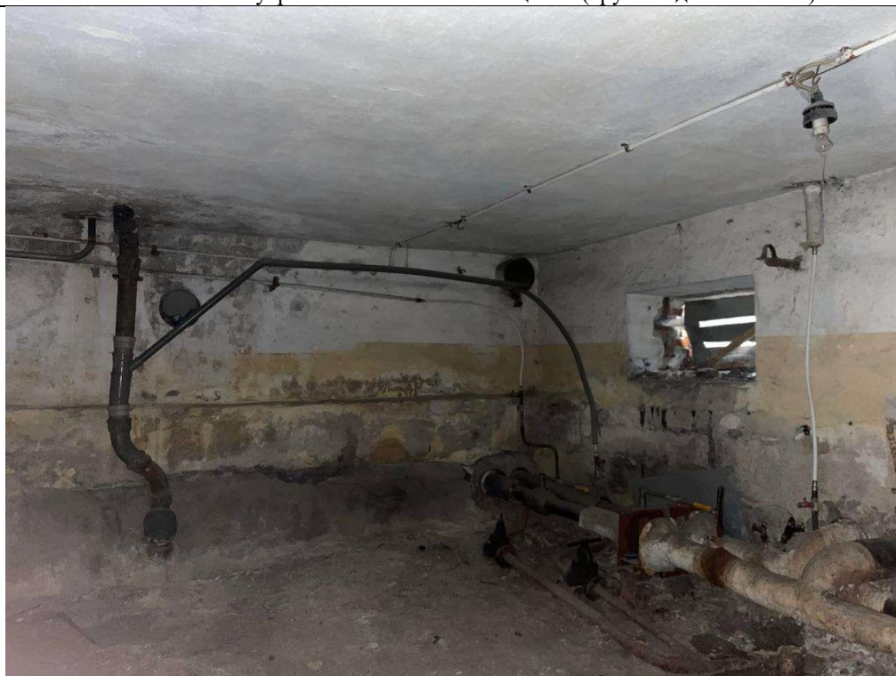
Фото № 22 – Внутреннее состояние помещения (канализационная труба)
