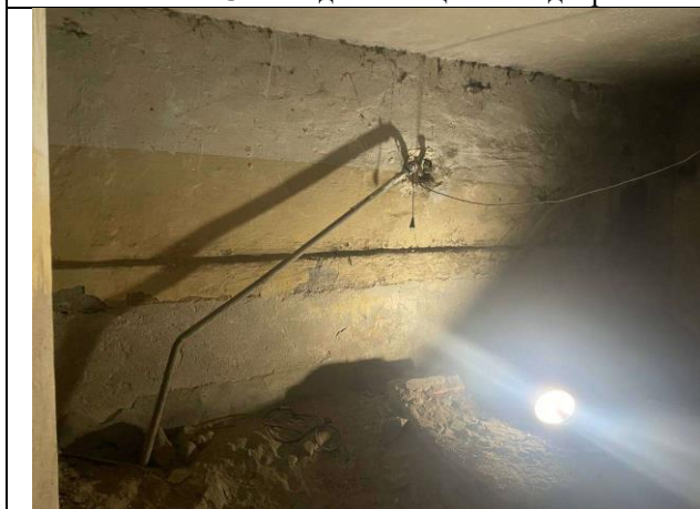
Фото № 7 – Внутреннее состояние помещения
