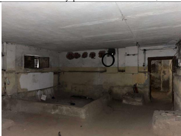
Фото № 19 – Внутреннее состояние помещения
