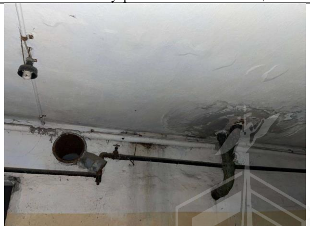
Фото № 20 – Внутреннее состояние помещения
