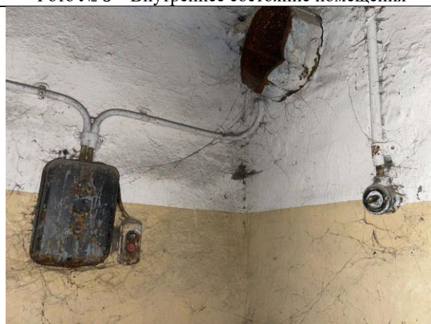
Фото № 10 – Внутреннее состояние помещения
