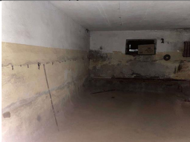
Фото № 15 – Внутреннее состояние помещения
