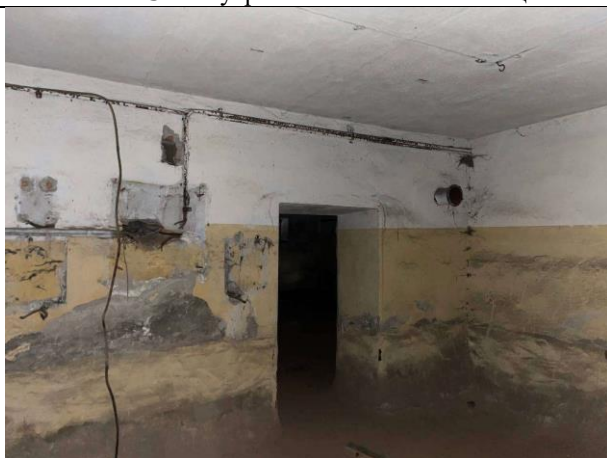
Фото № 17 – Внутреннее состояние помещения
