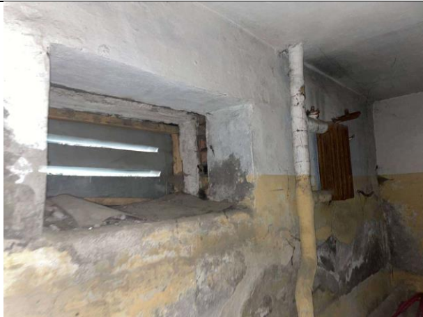
Фото № 13 – Внутреннее состояние помещения
