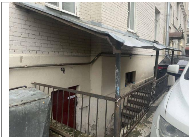
Фото № 5 – Вход в помещение со двора
