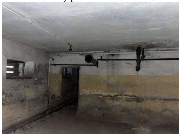
Фото № 8 – Внутреннее состояние помещения
