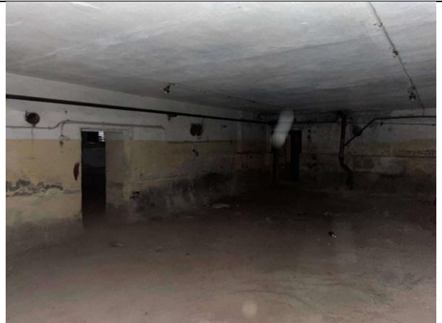
Фото № 14 – Внутреннее состояние помещения
