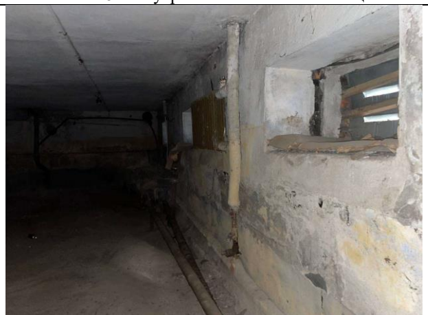
Фото № 18 – Внутреннее состояние помещения
