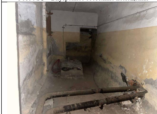
Фото № 11 – Внутреннее состояние помещения
