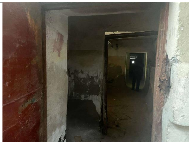
Фото № 6 – Внутреннее состояние помещения
