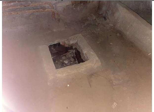
Фото № 16 – Внутреннее состояние помещения
