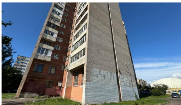
Фото 3. Вид здания Объекта оценки. Дворовая территория
