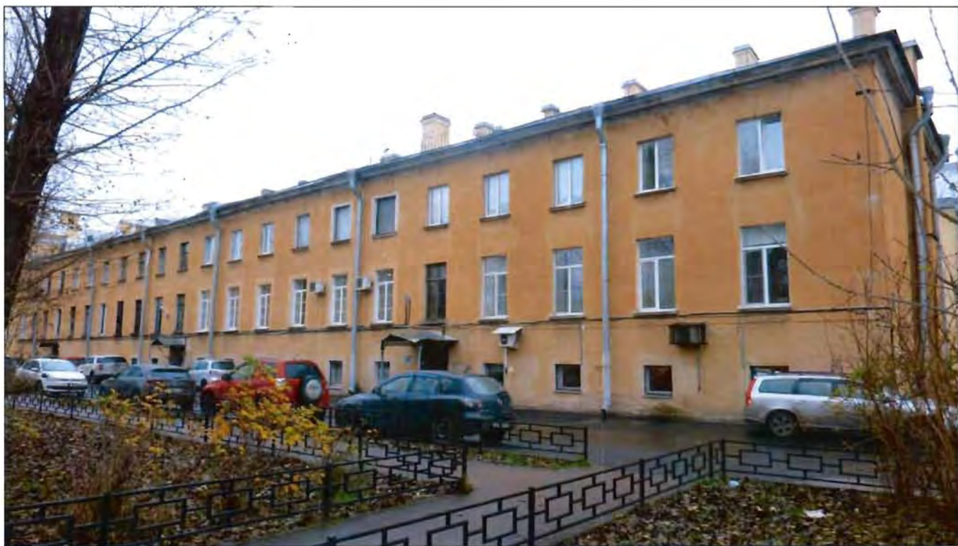
9. Корпус 2, литера Б. Вид с юга.
