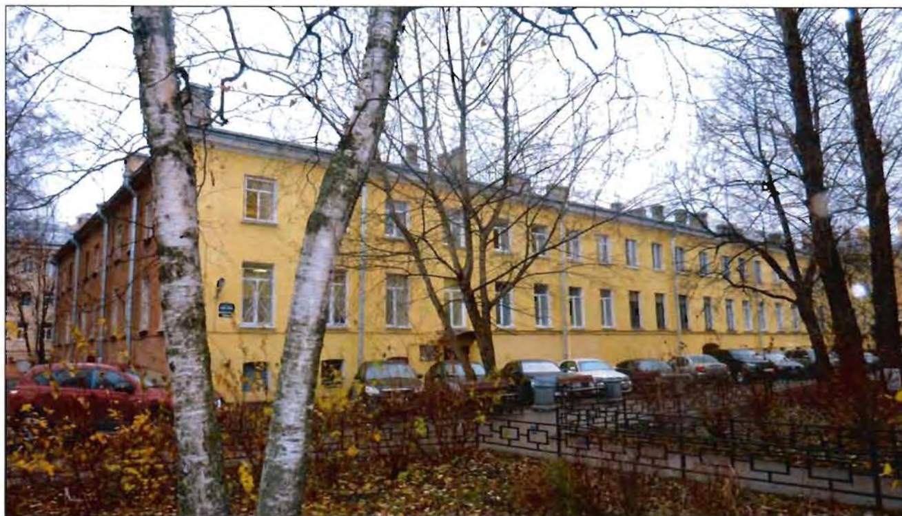
3. Корпус 3, литера В. Общий вид с востока.
