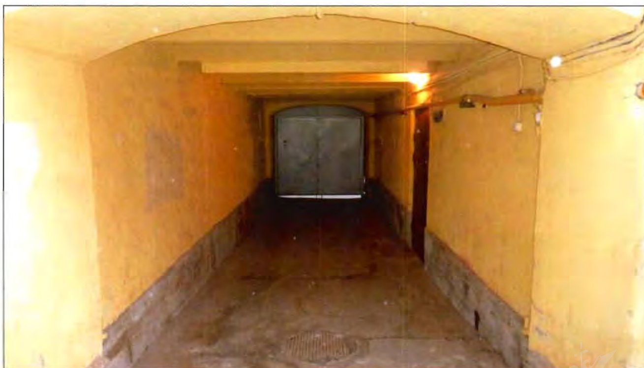
4. Корпус 3, литера В. Северный воротный проезд.
