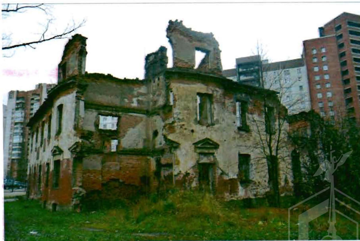
Фото №2. Северный фасад.
