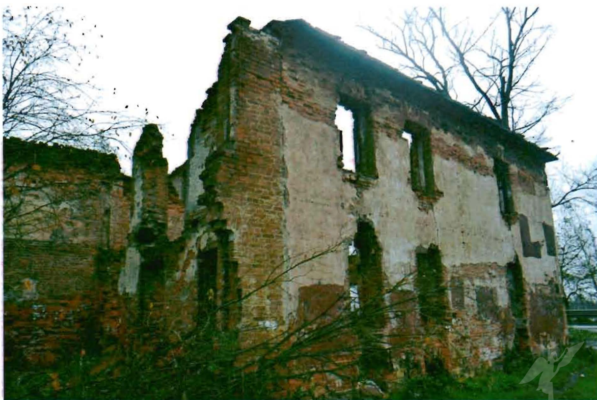
Фото №4. Южный фасад.
