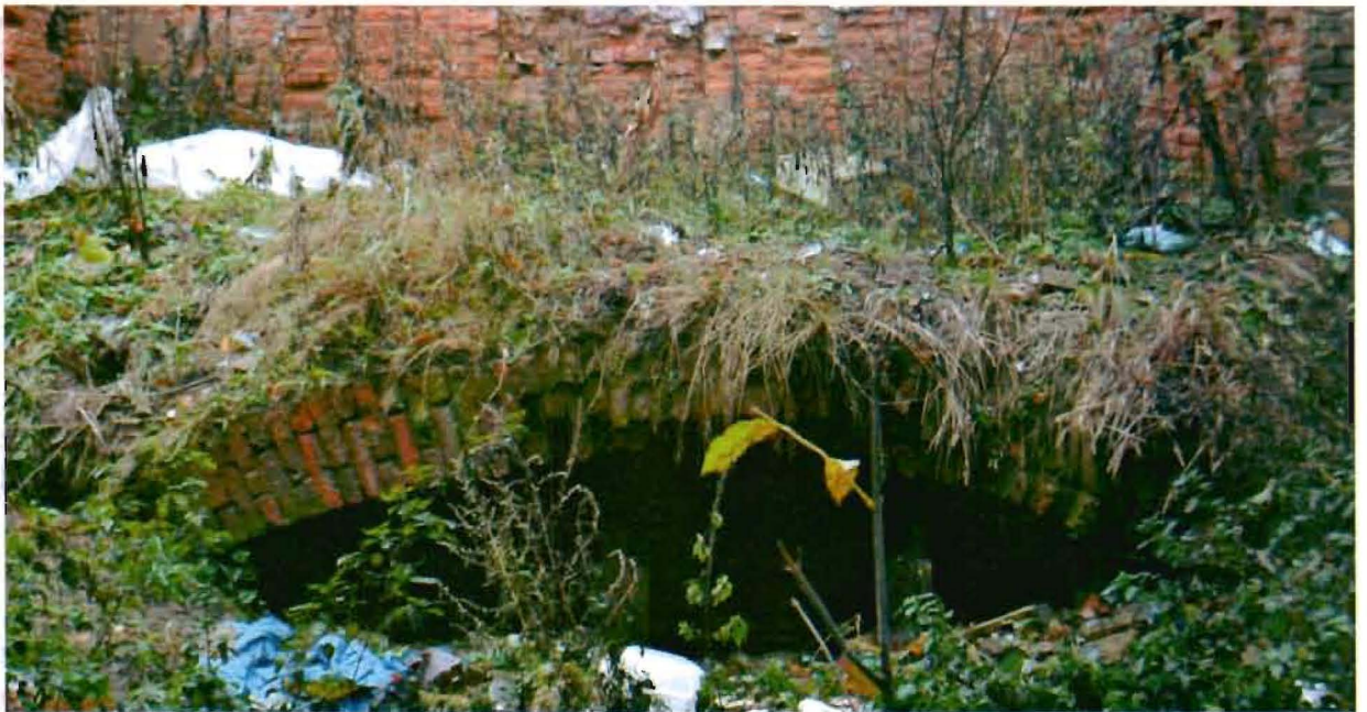
Фото №6. Интерьер. Часть свода подвала.
