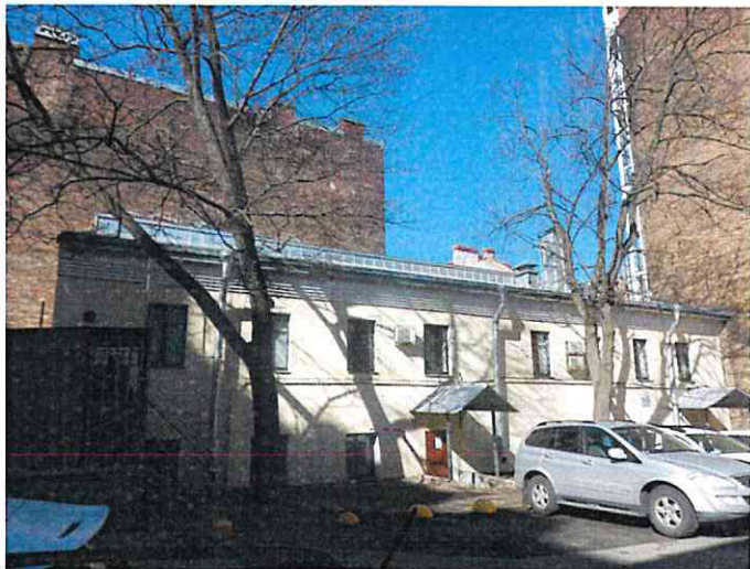
Фото №3 (вход в помещение)
