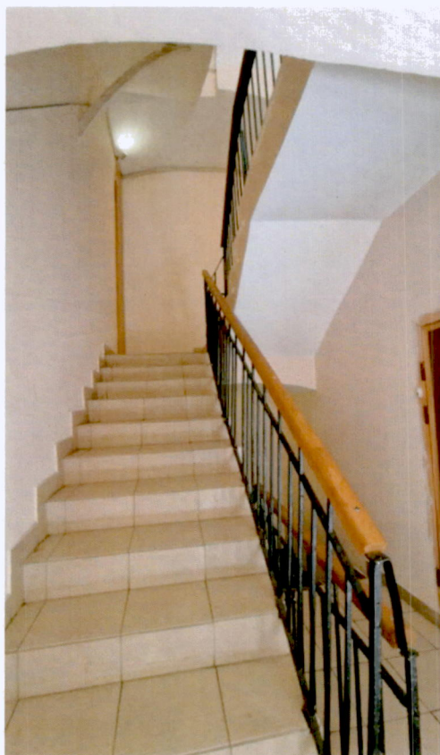
6. Лестница Л-3 (Фотография от 24.05.2024).
