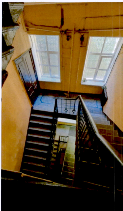
4. Лестница Л-1 (Фотография от 24.05.2024).
