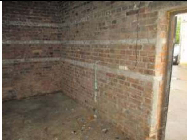
Фото № 17. Внутреннее состояние здания
