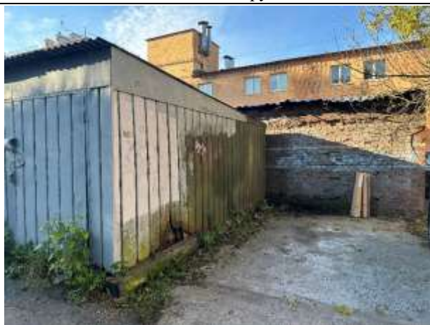
Фото № 5. Внешний вид здания
