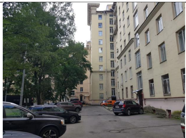
Фото 2. Вид здания, в котором расположен Объект оценки
