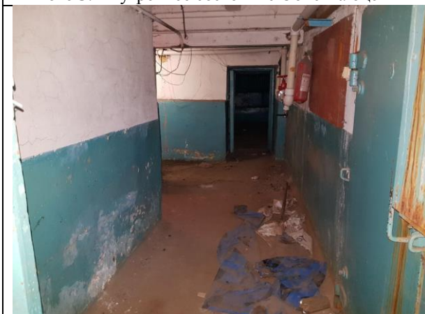
Фото 11. Внутреннее состояние Объекта оценки
