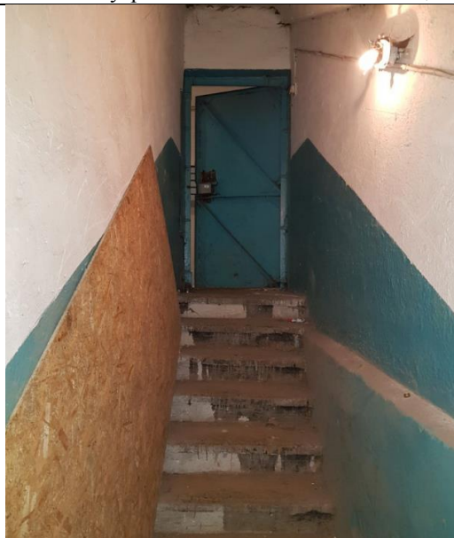
Фото 15. Внутреннее состояние Объекта оценки
