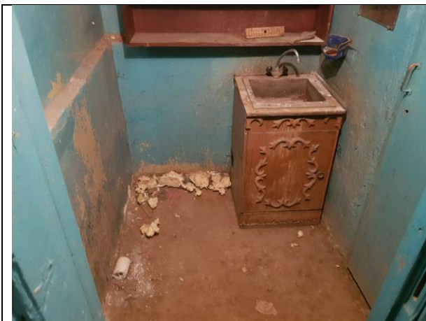
Фото 19. Внутреннее состояние Объекта оценки
