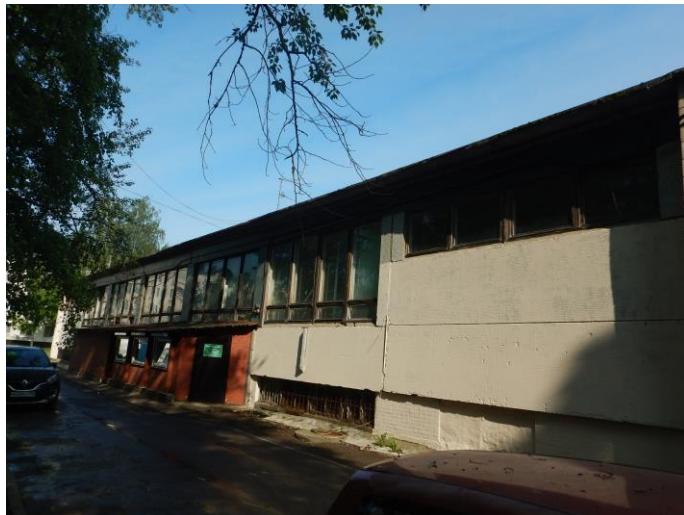
Фото №4 (вход в пом.6-Н)
