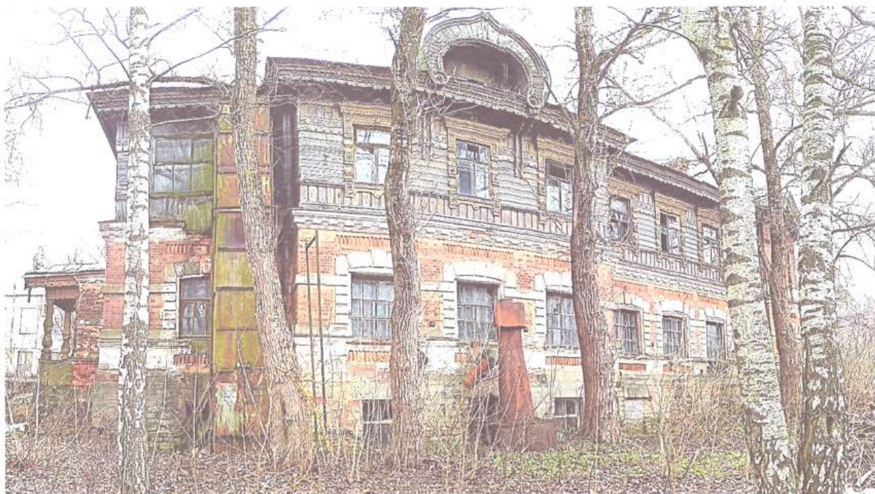
Фото 17. Вид на западный фасад
