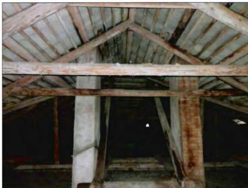
5. Стропильная система. Общий вид.
