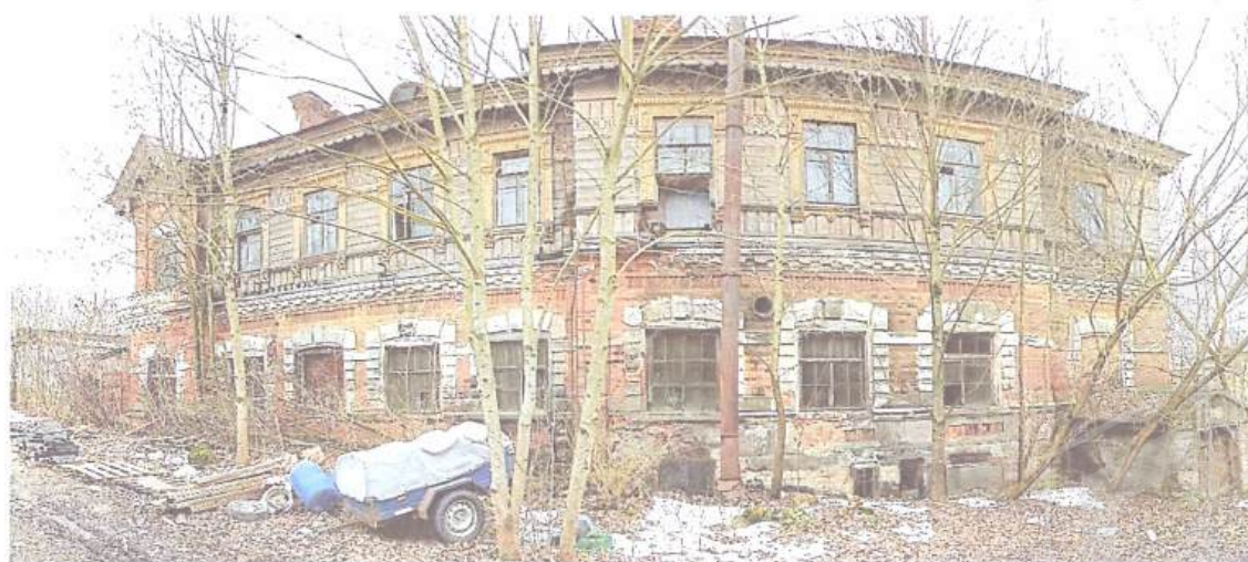
Фото 6. Панорамный вид на восточный фасад
