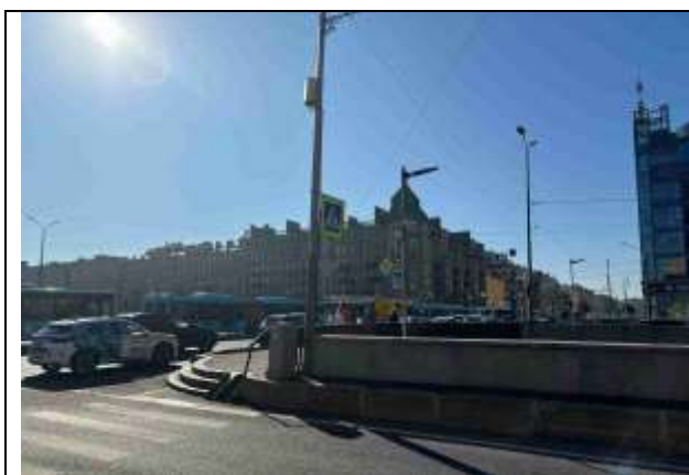
Фото 1. Ближайшее окружение Объекта оценки (Лиговский проспект)
