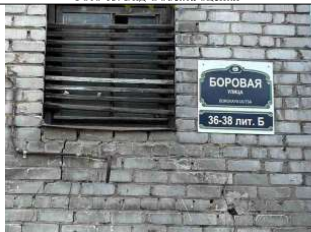
Фото 17. Адрес Объекта оценки
