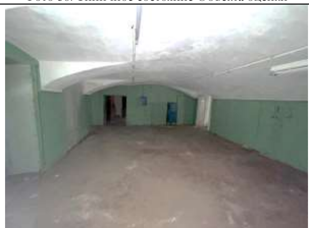
Фото 60. Типичное состояние Объекта оценки
