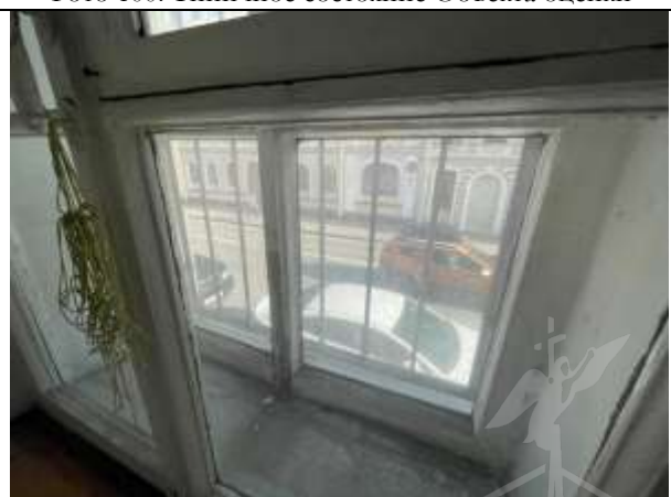
Фото 102. Оконная группа Объекта оценки, вид на улицу
