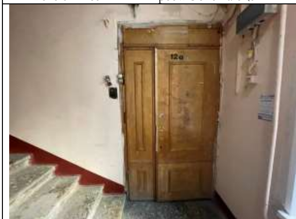
Фото 53. Лестничный проём Объекта оценки
