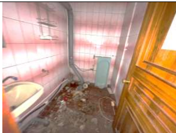
Фото 119. Типичное состояние Объекта оценки
