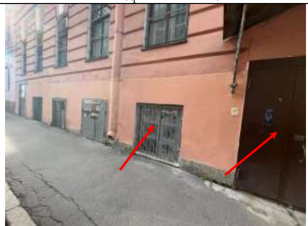
Фото 18. Входная и оконная группа Объекта оценки
