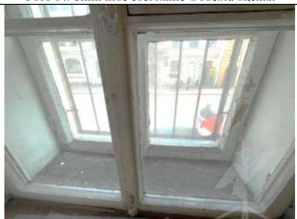
Фото 86. Оконная группа Объекта оценки, вид на улицу
