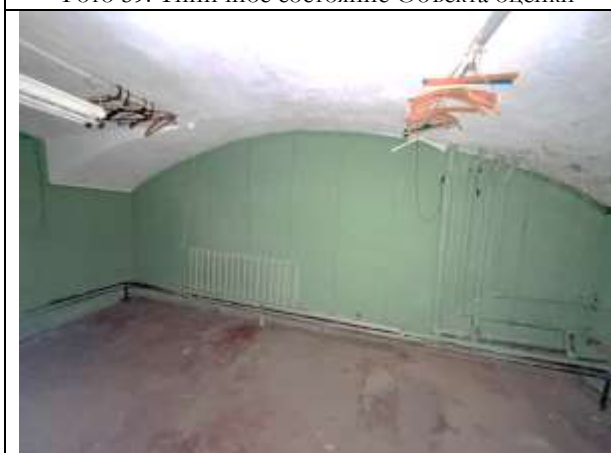
Фото 61. Типичное состояние Объекта оценки
