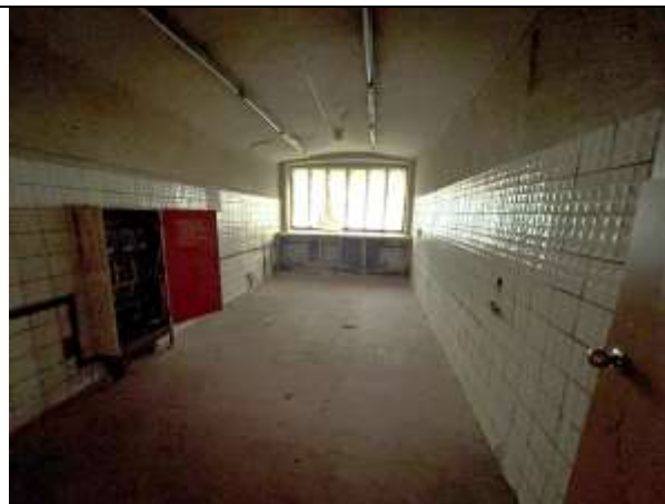
Фото 31. Типичное состояние Объекта оценки
