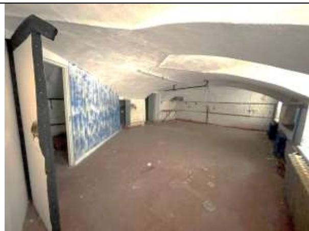
Фото 112. Типичное состояние Объекта оценки
