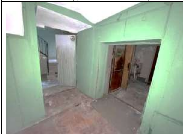
Фото 57. Типичное состояние Объекта оценки
