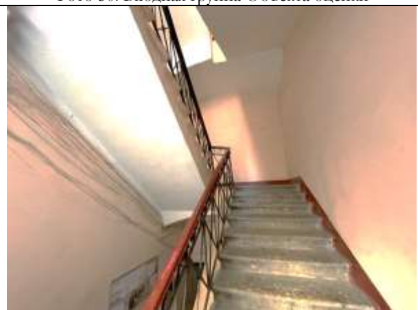
Фото 52. Лестничный проём Объекта оценки
