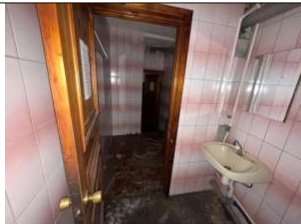
Фото 120. Типичное состояние Объекта оценки
