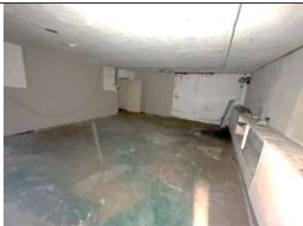
Фото 40. Типичное состояние Объекта оценки
