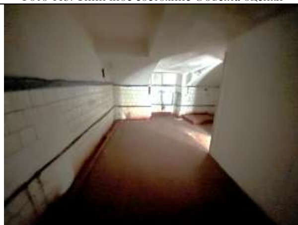
Фото 115. Типичное состояние Объекта оценки
