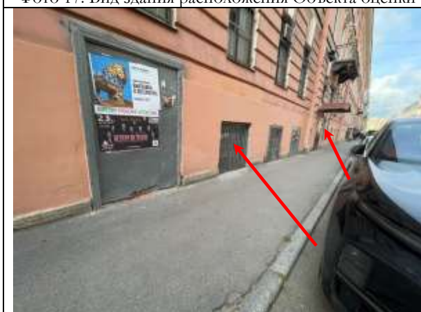
Фото 19. Входная и оконная группа Объекта оценки
