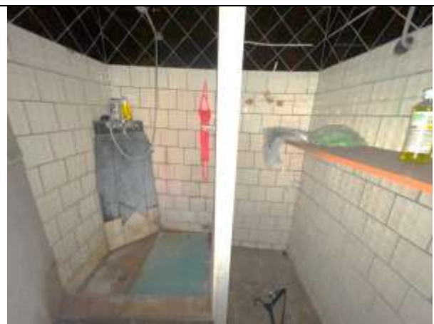
Фото 48. Типичное состояние Объекта оценки
