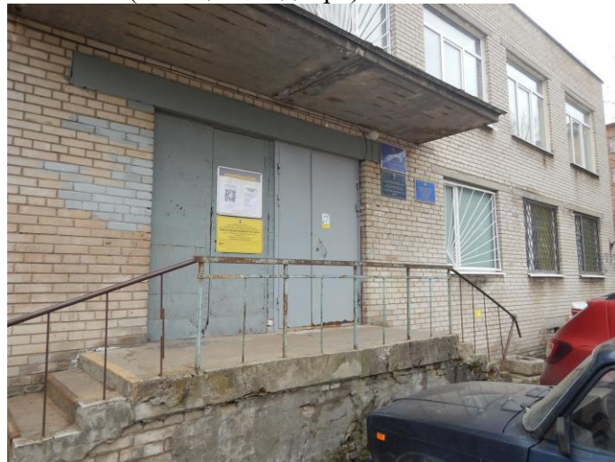
Фото №4 (вход в помещение)
