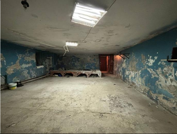
Фото № 15 – Внутреннее состояние помещения
