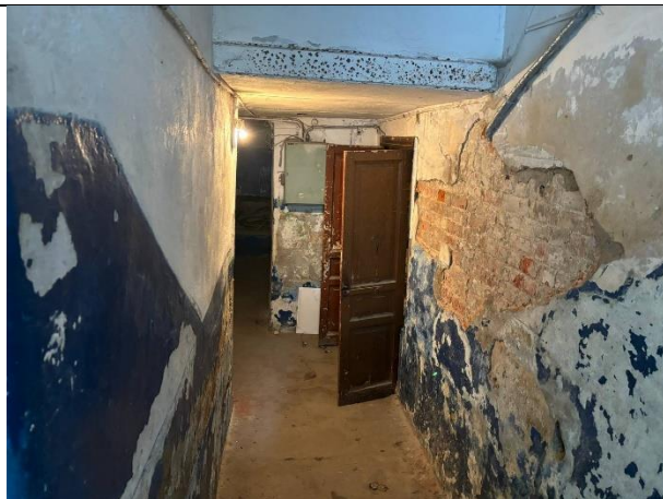
Фото № 21 – Внутреннее состояние помещения
