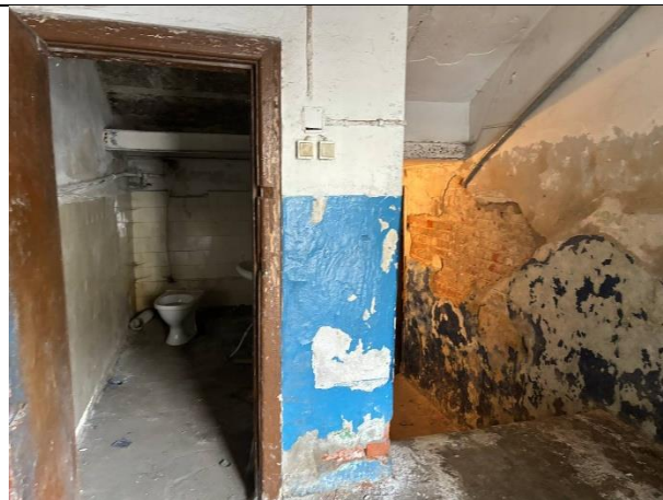
Фото № 22 – Внутреннее состояние помещения
