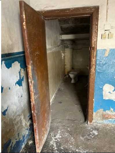
Фото № 17 – Внутреннее состояние помещения
