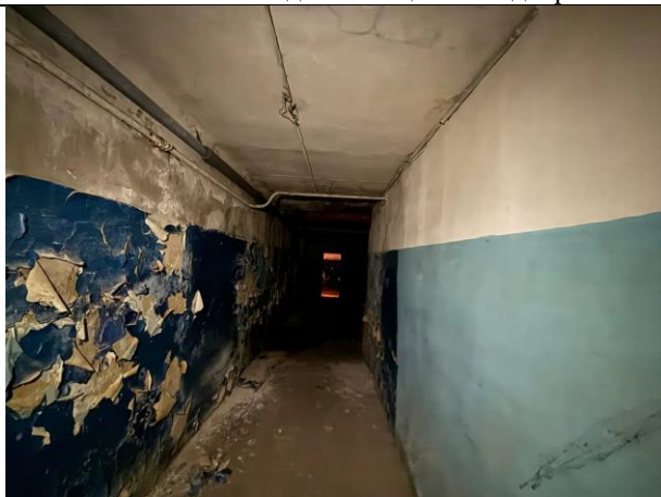
Фото № 9 – Внутреннее состояние помещения с
