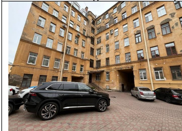
Фото № 3 – Здание, в котором находится Объект оценки
