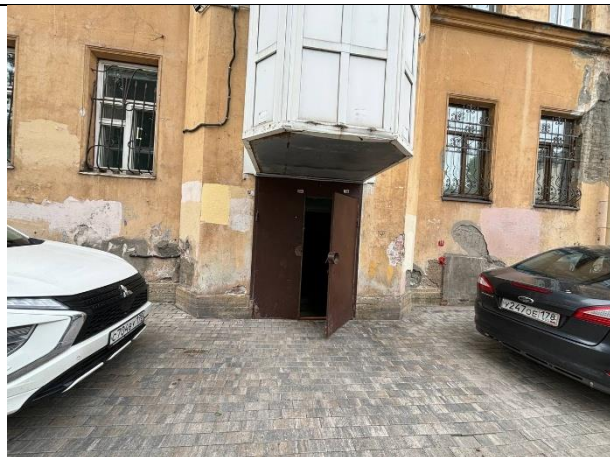
Фото № 8 – Вход в помещение со двора
