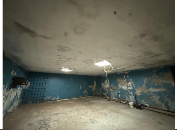
Фото № 16 – Внутреннее состояние помещения
