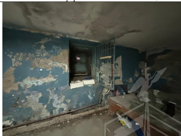
Фото № 14 – Внутреннее состояние помещения
