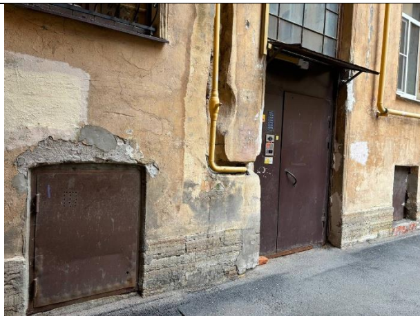
Фото № 7 – Вход в помещение со двора
