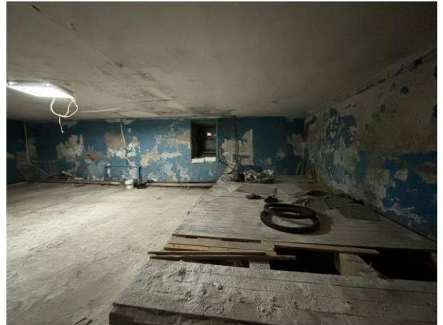
Фото № 18 – Внутреннее состояние помещения
