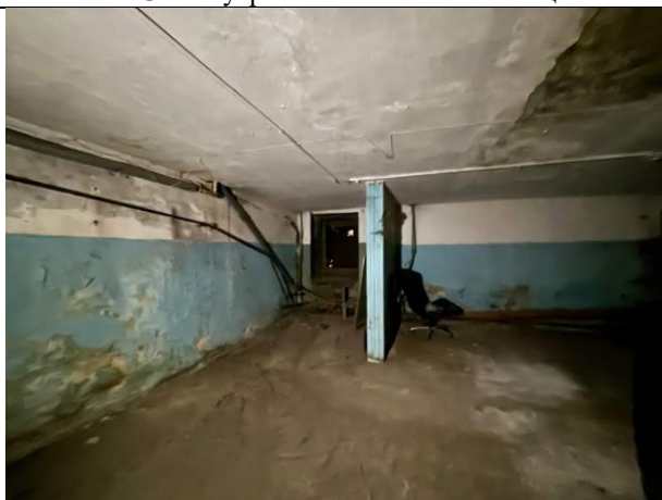
Фото № 11 – Внутреннее состояние помещения с
