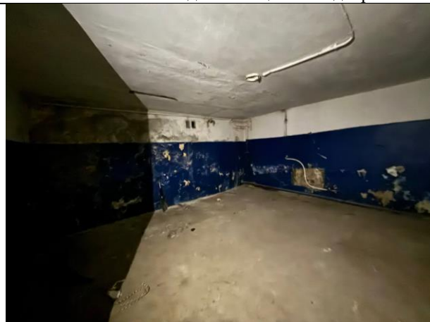
Фото № 10 – Внутреннее состояние помещения
