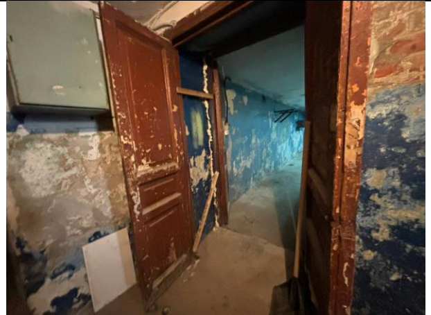
Фото № 20 – Внутреннее состояние помещения
