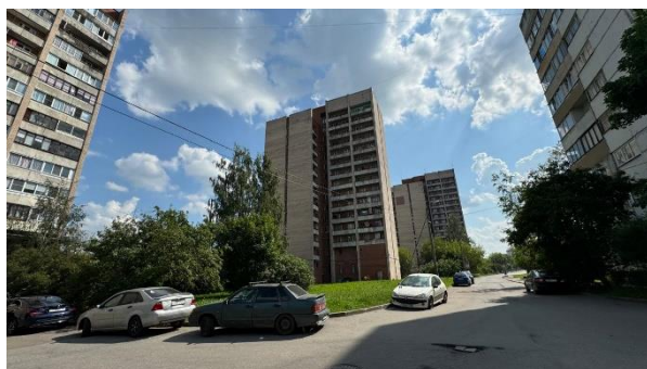
Фото 3. Вид здания Объекта оценки. Дворовая территория
