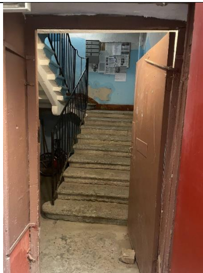
Фото № 14 – Внутреннее состояние помещения
