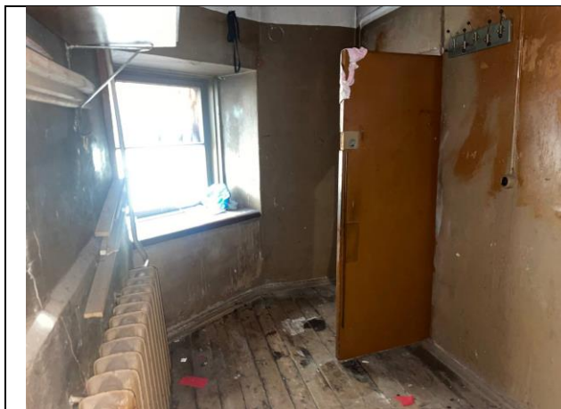
Фото № 19 – Внутреннее состояние помещения
