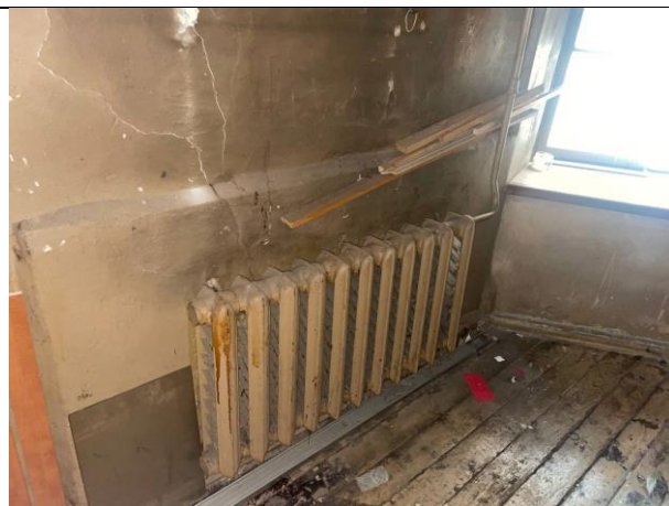
Фото № 20 – Внутреннее состояние помещения
