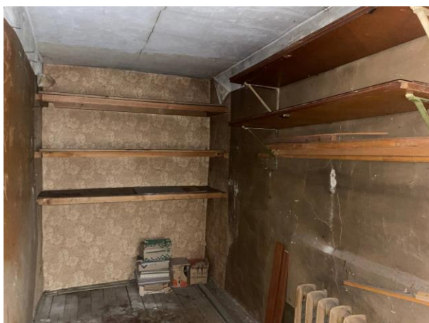
Фото № 17 – Внутреннее состояние помещения
