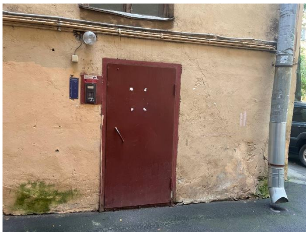
Фото № 13 – Общий вход к помещению с улицы
