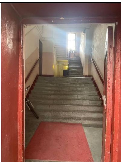
Фото № 9 – Парадная дома № 10, через который необходимо пройти, чтобы оказаться во дворе
