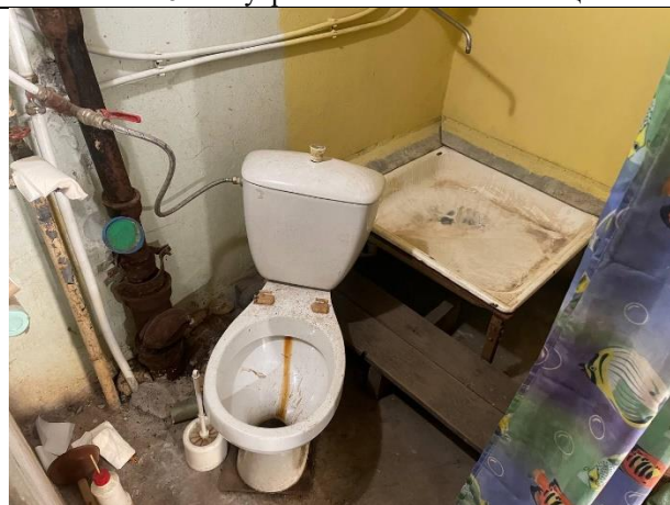
Фото № 12 – Внутреннее состояние помещения
