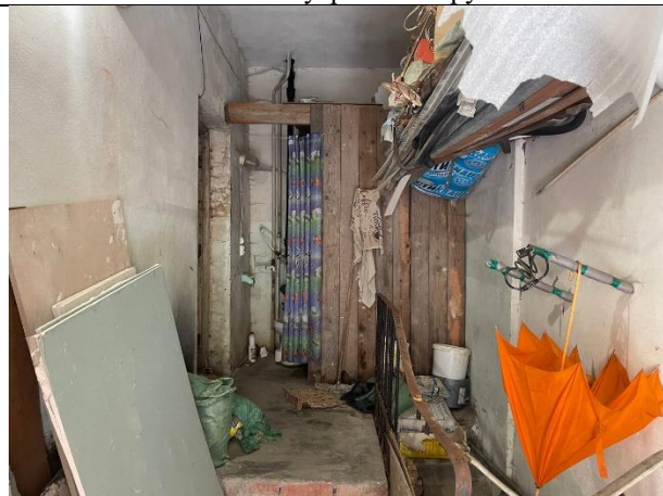
Фото № 10 – Внутреннее состояние помещения
