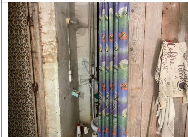
Фото № 11 – Внутреннее состояние помещения
