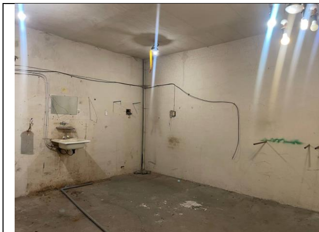
Фото № 15 – Внутреннее состояние помещения
