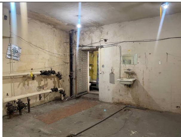
Фото № 16 – Внутреннее состояние помещения
