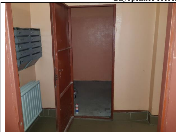
Фото 7. Внутреннее состояние Объекта оценки
