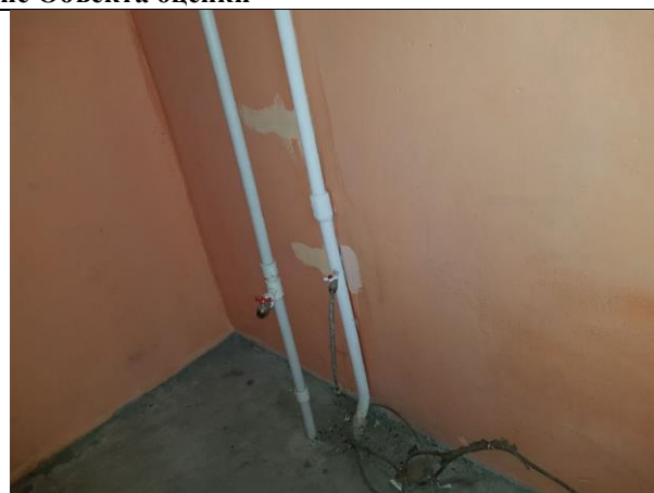
Фото 8. Внутреннее состояние Объекта оценки
