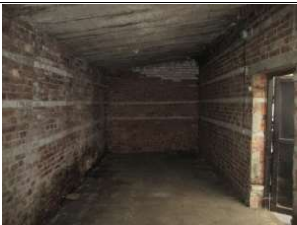
Фото № 11. Внутреннее состояние здания
