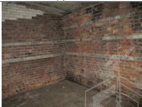
Фото № 14. Внутреннее состояние здания
