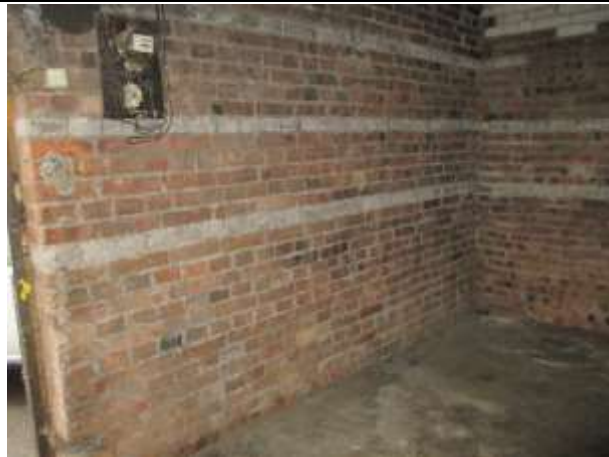
Фото № 18. Внутреннее состояние здания
