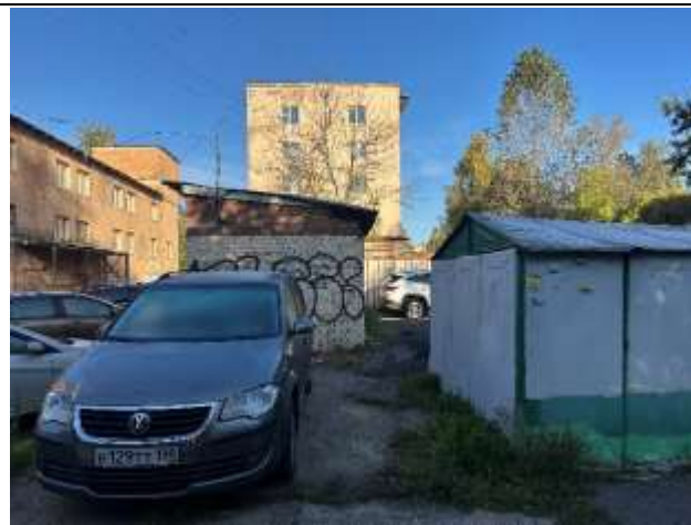
Фото № 8. Внешний вид здания
