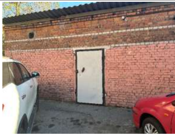
Фото № 10. Вход в здание
