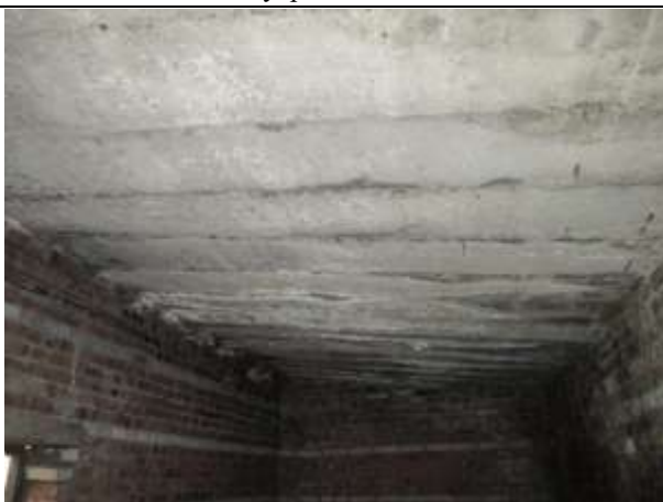
Фото № 13. Внутреннее состояние здания
