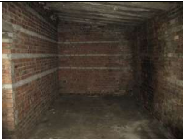
Фото № 12. Внутреннее состояние здания
