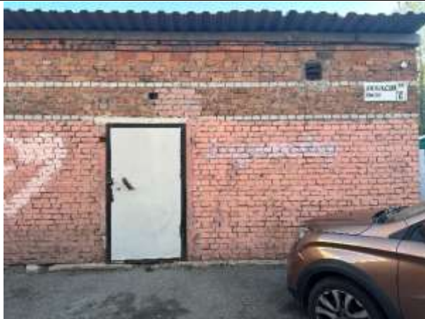
Фото № 9. Вход в здание
