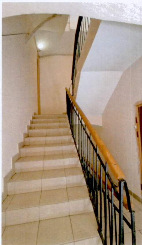
6. Лестница Л-3 (Фотография от 24.05.2024).
